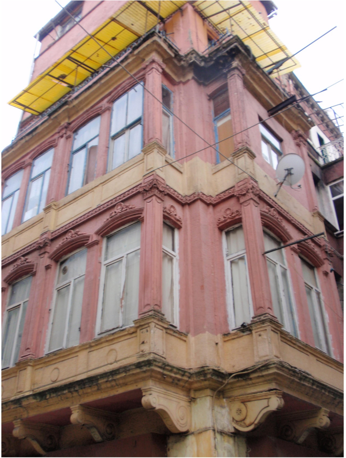
Şekil A.42: 42 No'lu Eklektik Dönemi Binası
