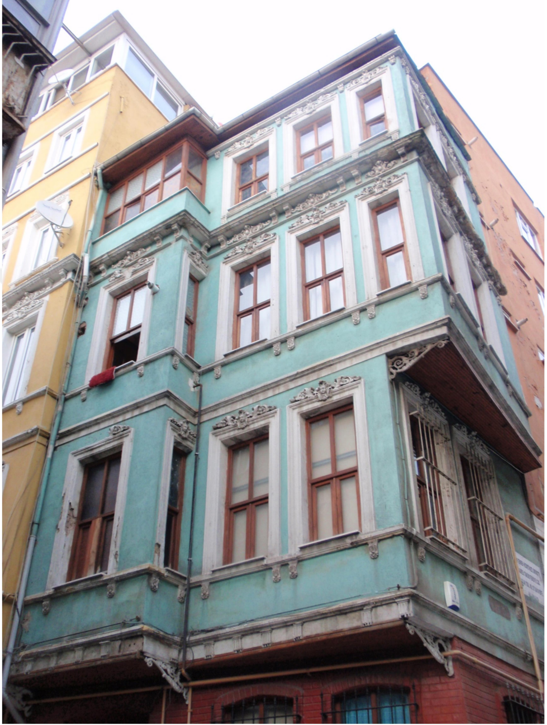
Şekil A.12 : 12 No'lu Eklektik Dönemi Binası
