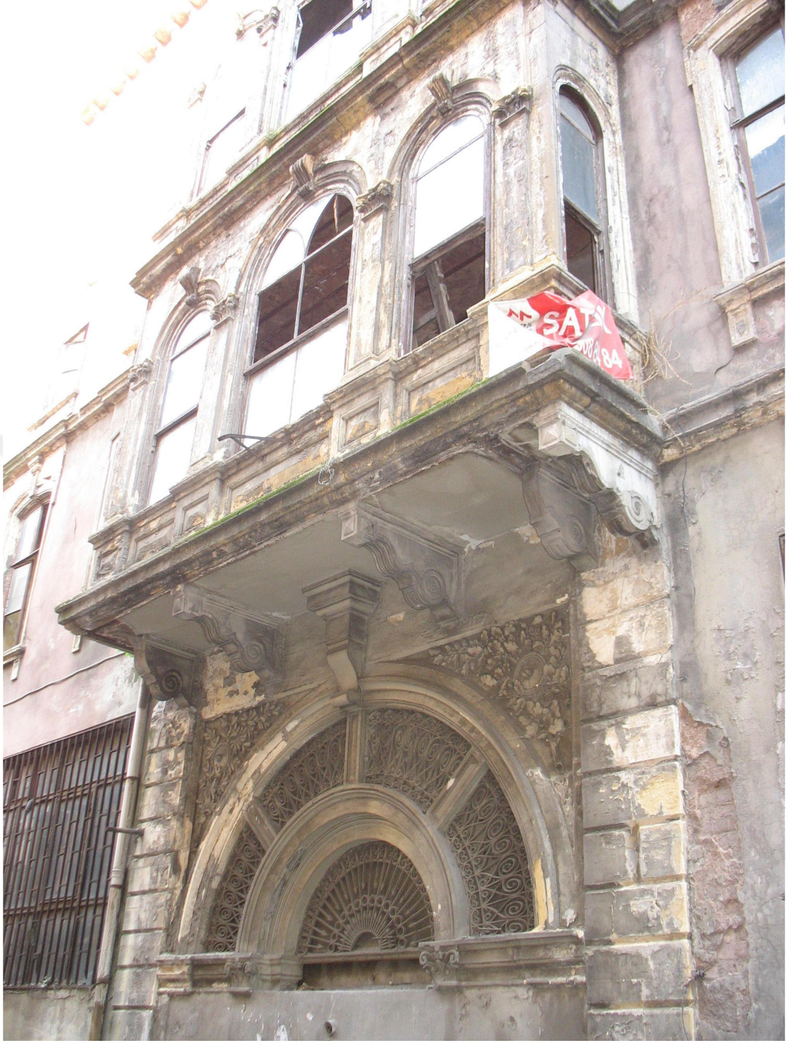
Şekil A.30: 30 No'lu Eklektik Dönemi Binası
