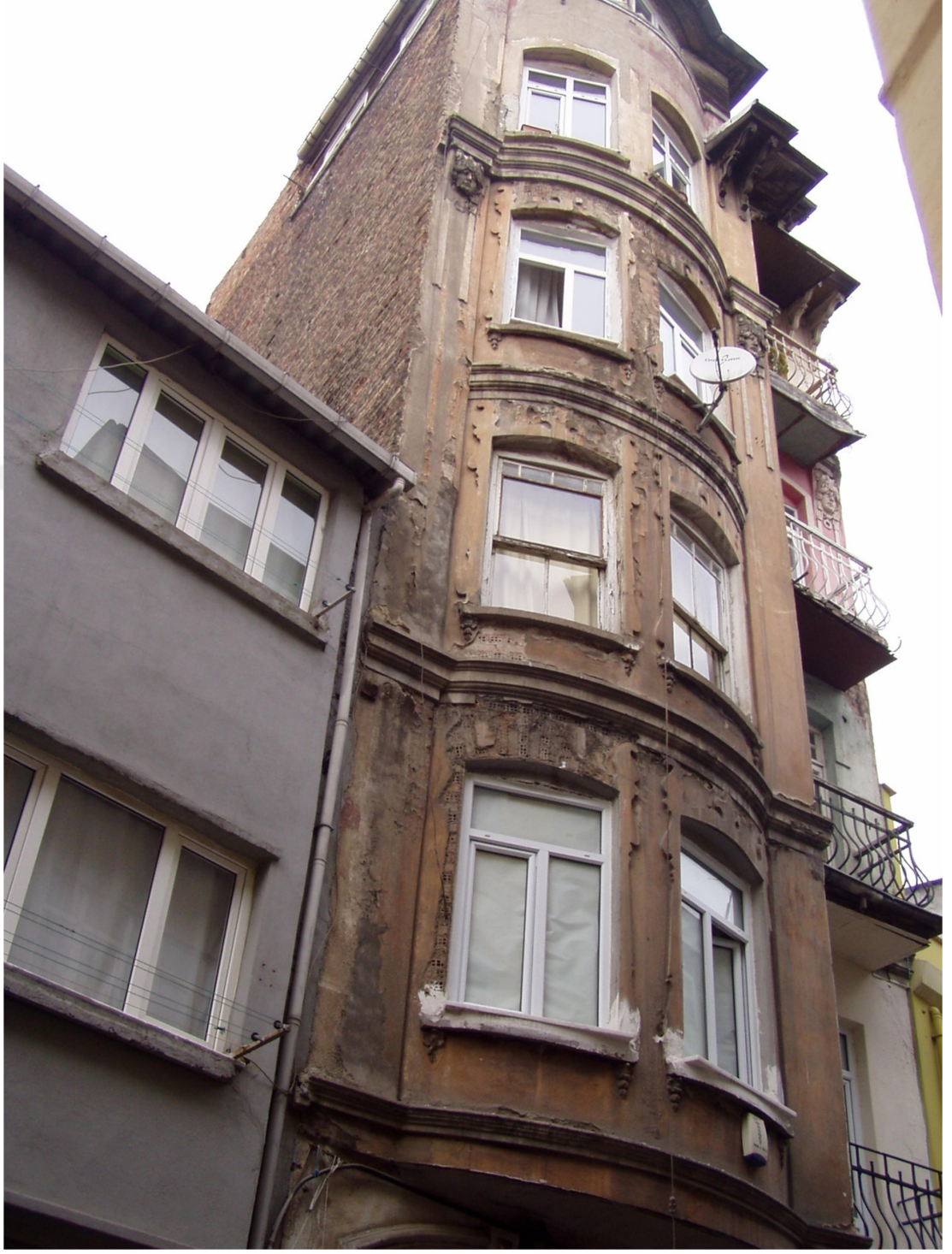
Şekil A.34: 34 No'lu Eklektik Dönemi Binası
