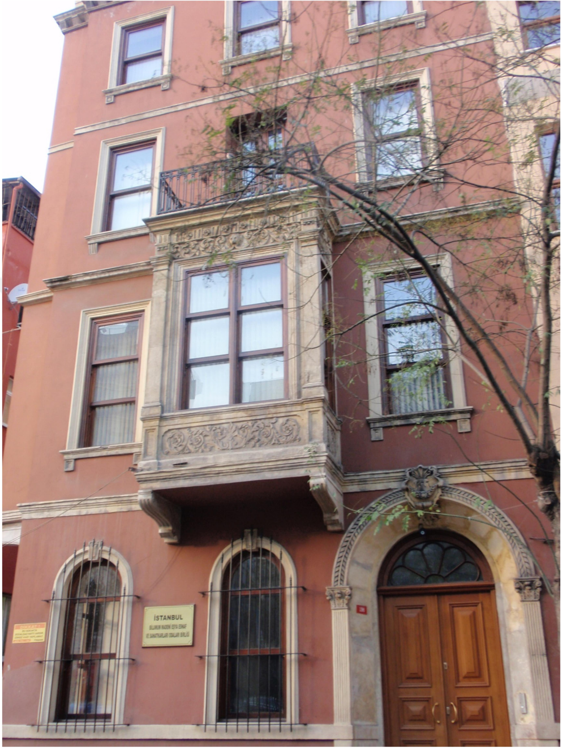
Şekil A.36: 36 No'lu Eklektik Dönemi Binası
