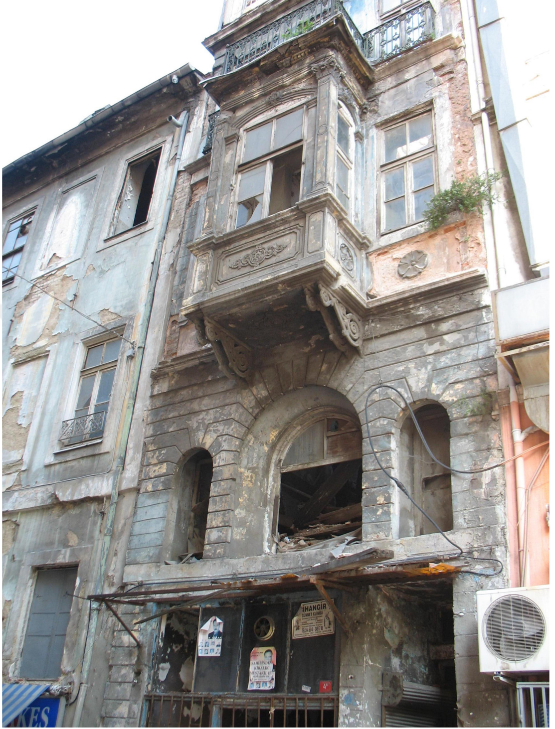
Şekil A.28 : 28 No'lu Eklektik Dönemi Binası
