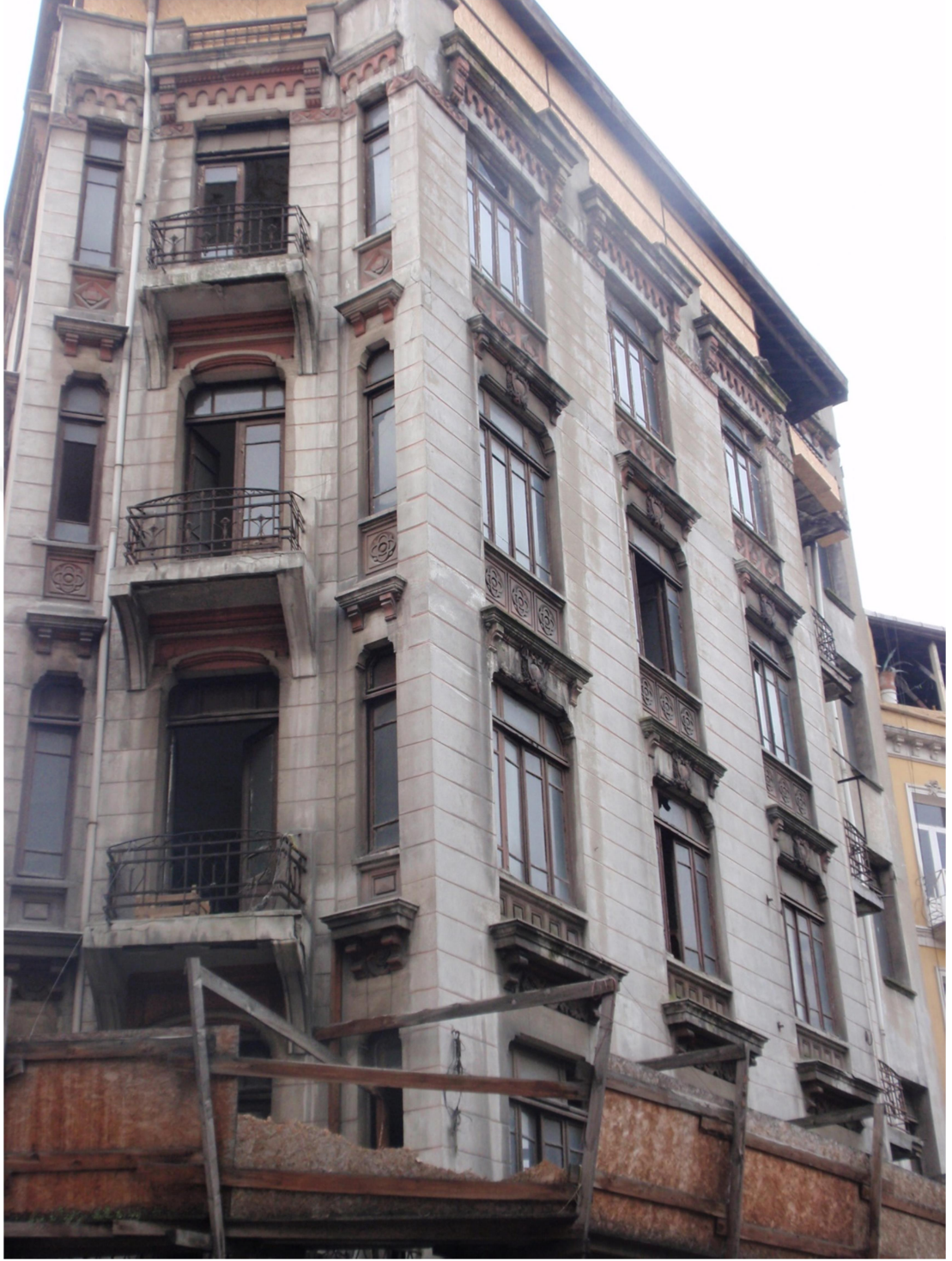
Şekil A.35: 35 No'lu Eklektik Dönemi Binası
