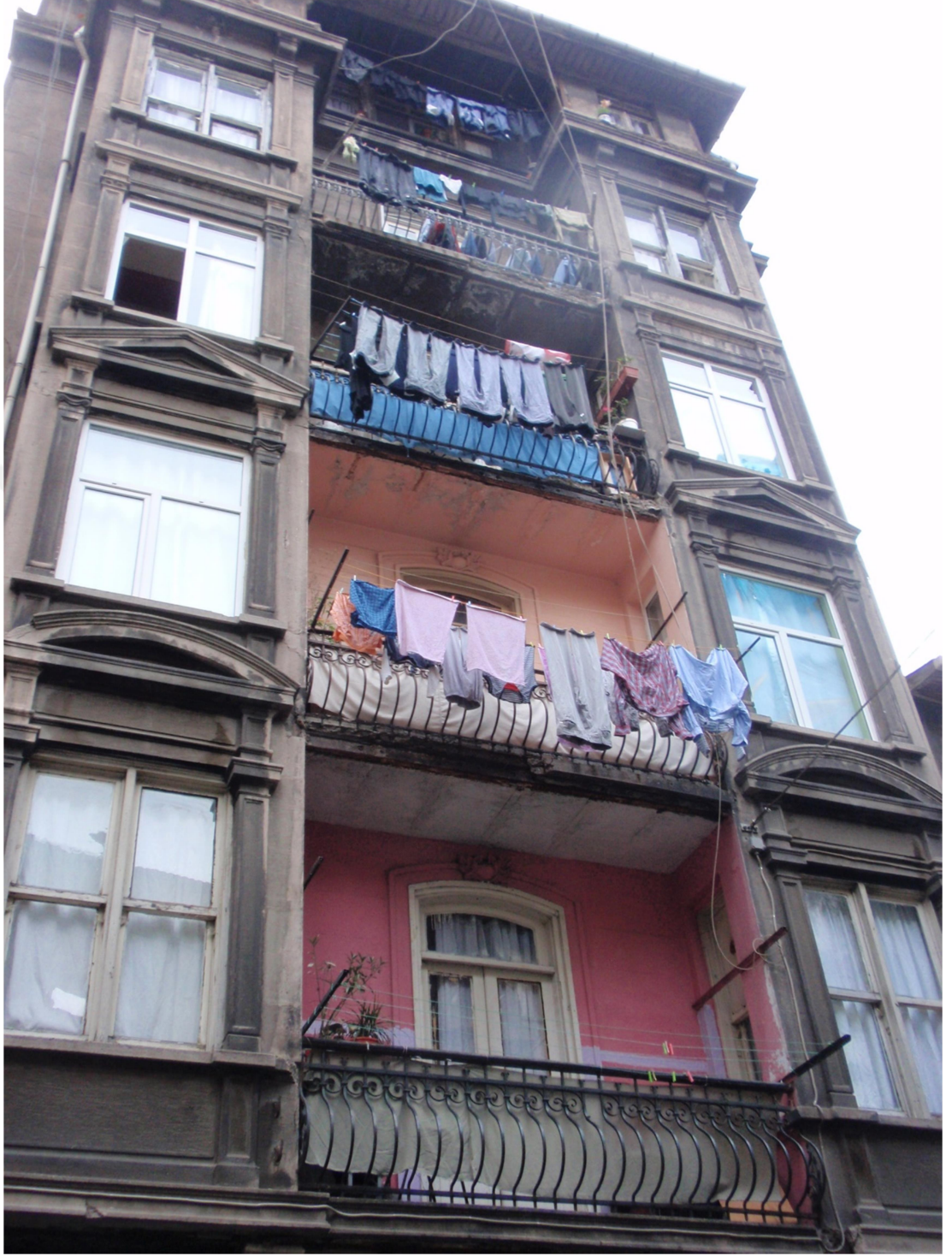
Şekil A.14 : 14 No'lu Eklektik Dönemi Binası
