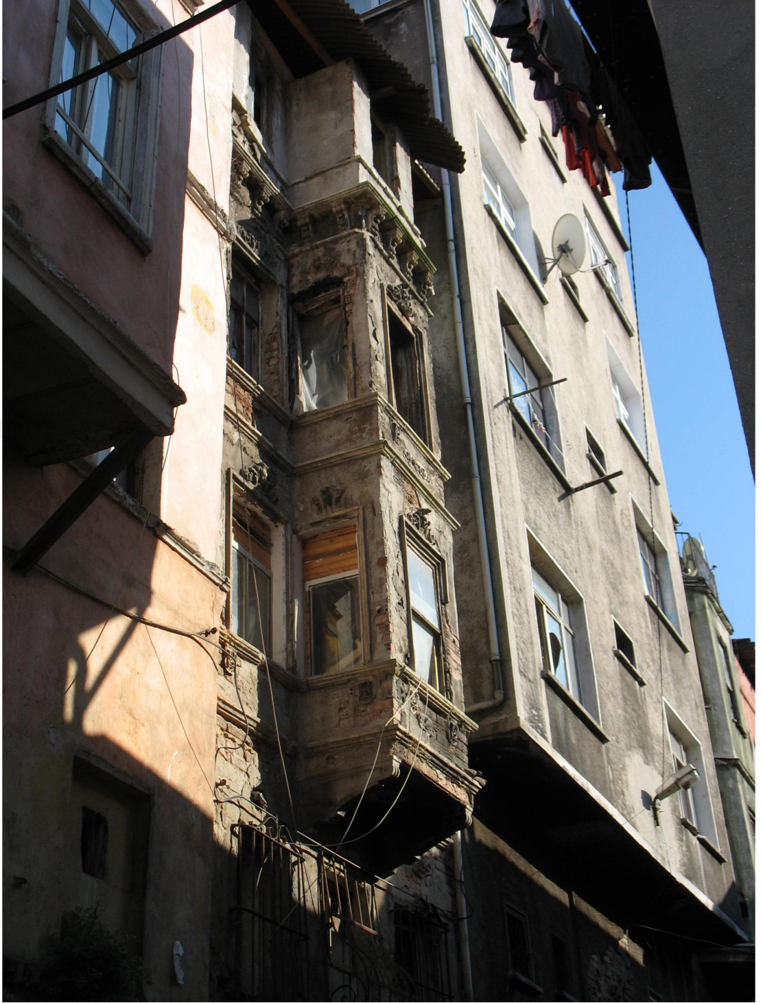
Şekil A.27 : 27 No'lu Eklektik Dönemi Binası
