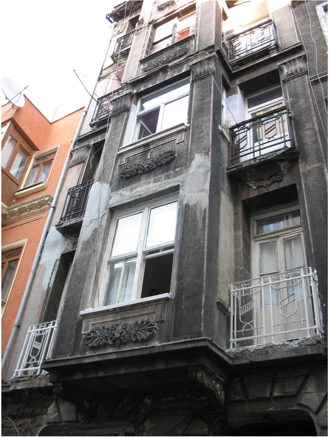
Şekil A.31: 31 No'lu Eklektik Dönemi Binası
