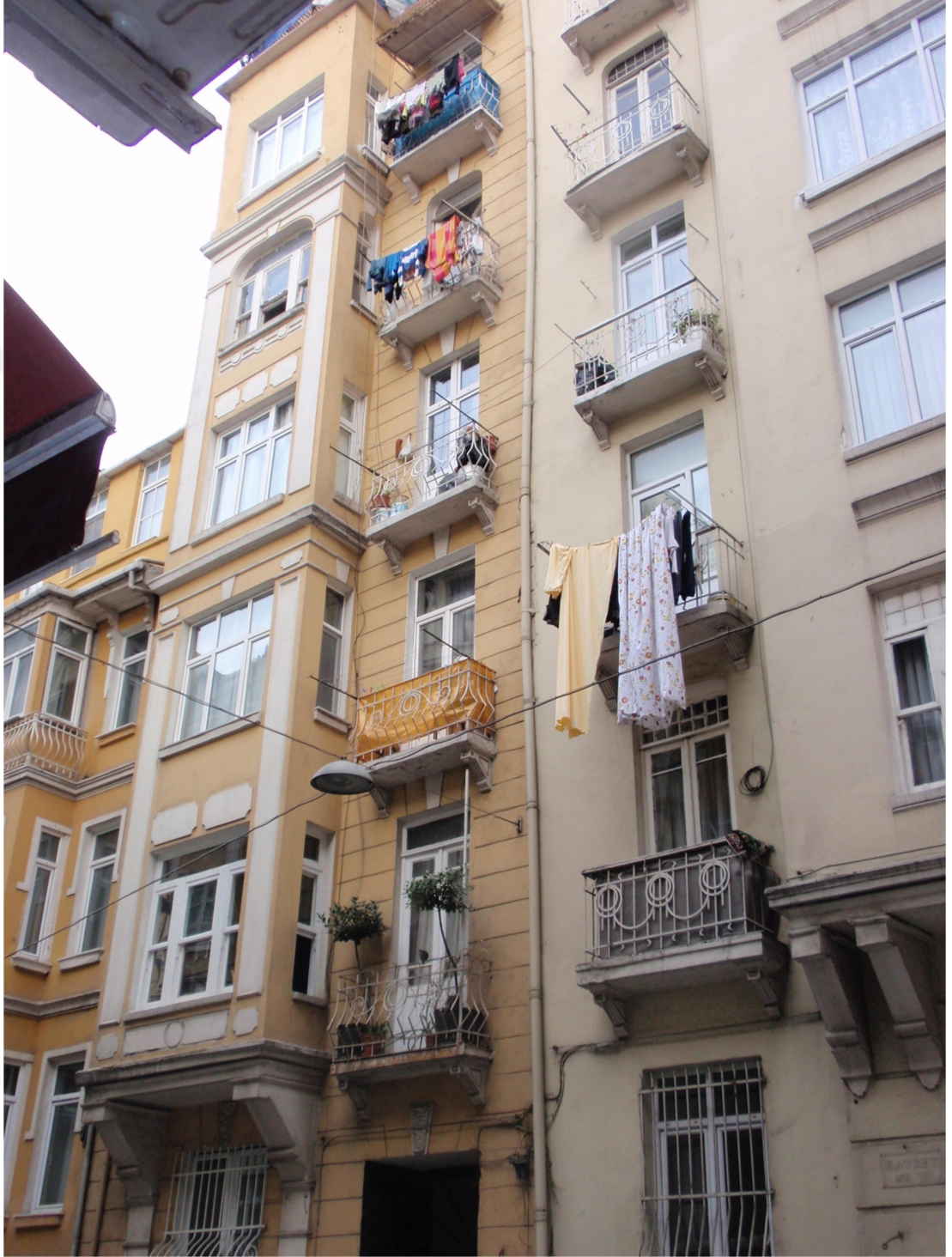
Şekil A.8 : 8 No'lu Eklektik Dönemi Binası (Geç Dönem)
