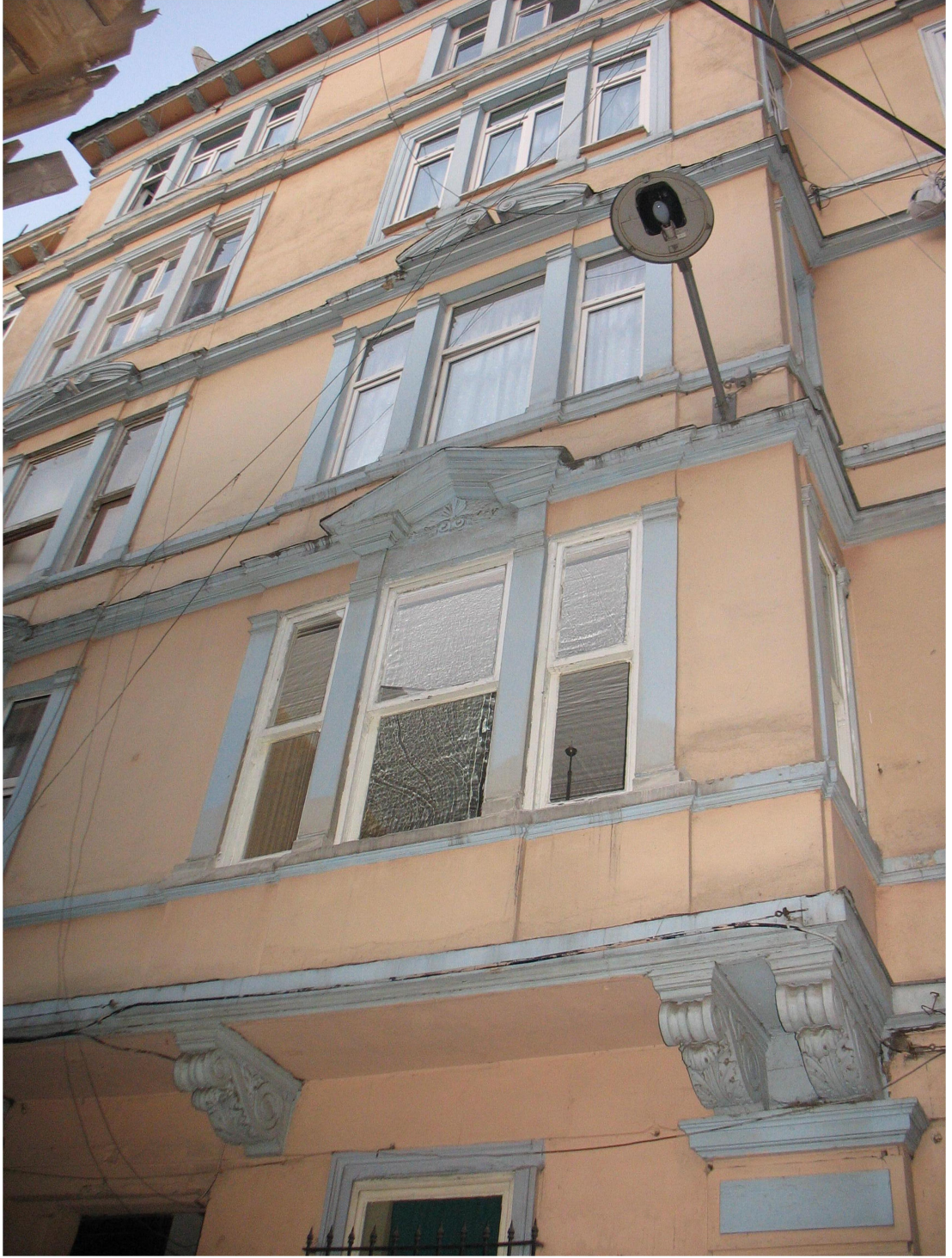
Şekil A.15 : 15 No'lu Eklektik Dönemi Binası
