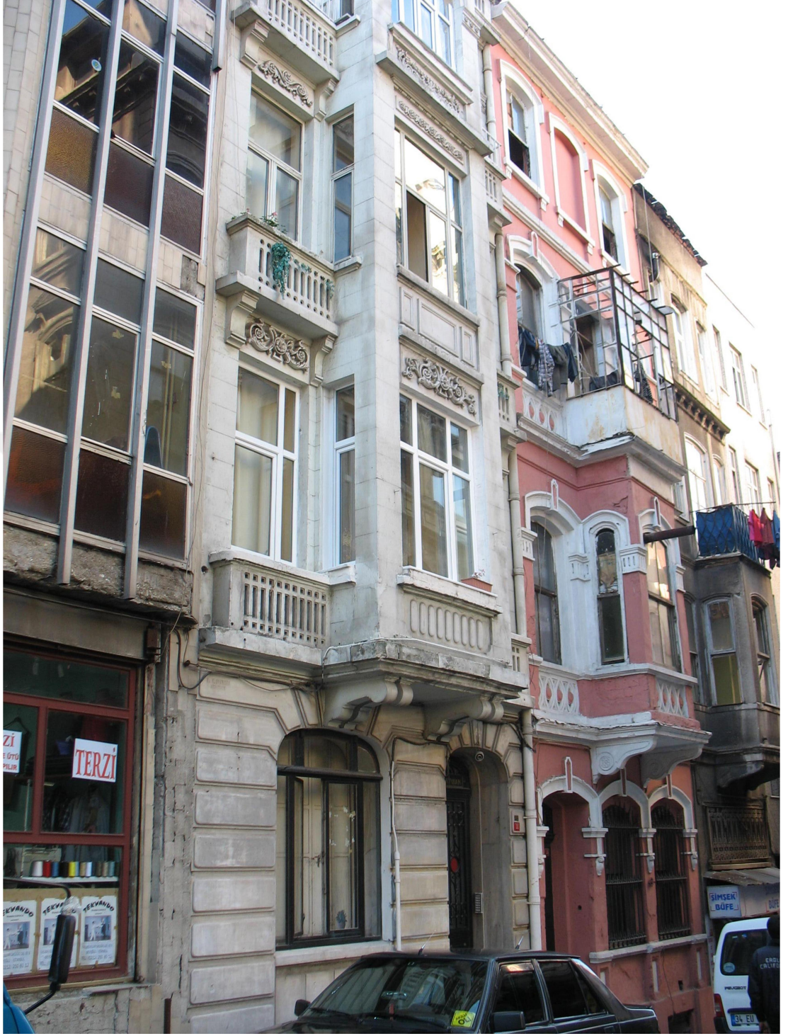
Şekil A.29 : 29 No'lu Eklektik Dönemi Binası
