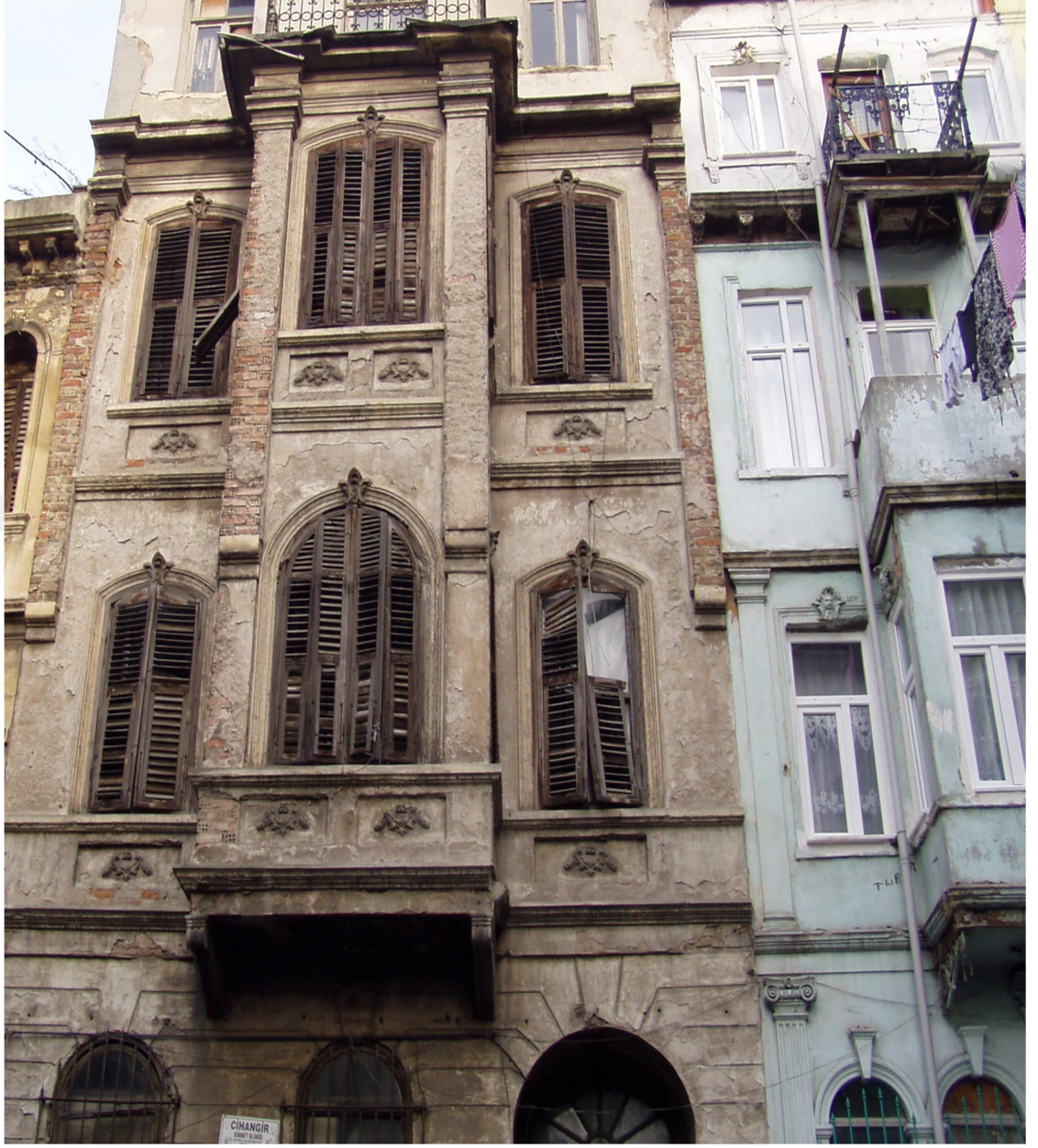
Şekil A.25 : 25 No'lu Eklektik Dönemi Binası
