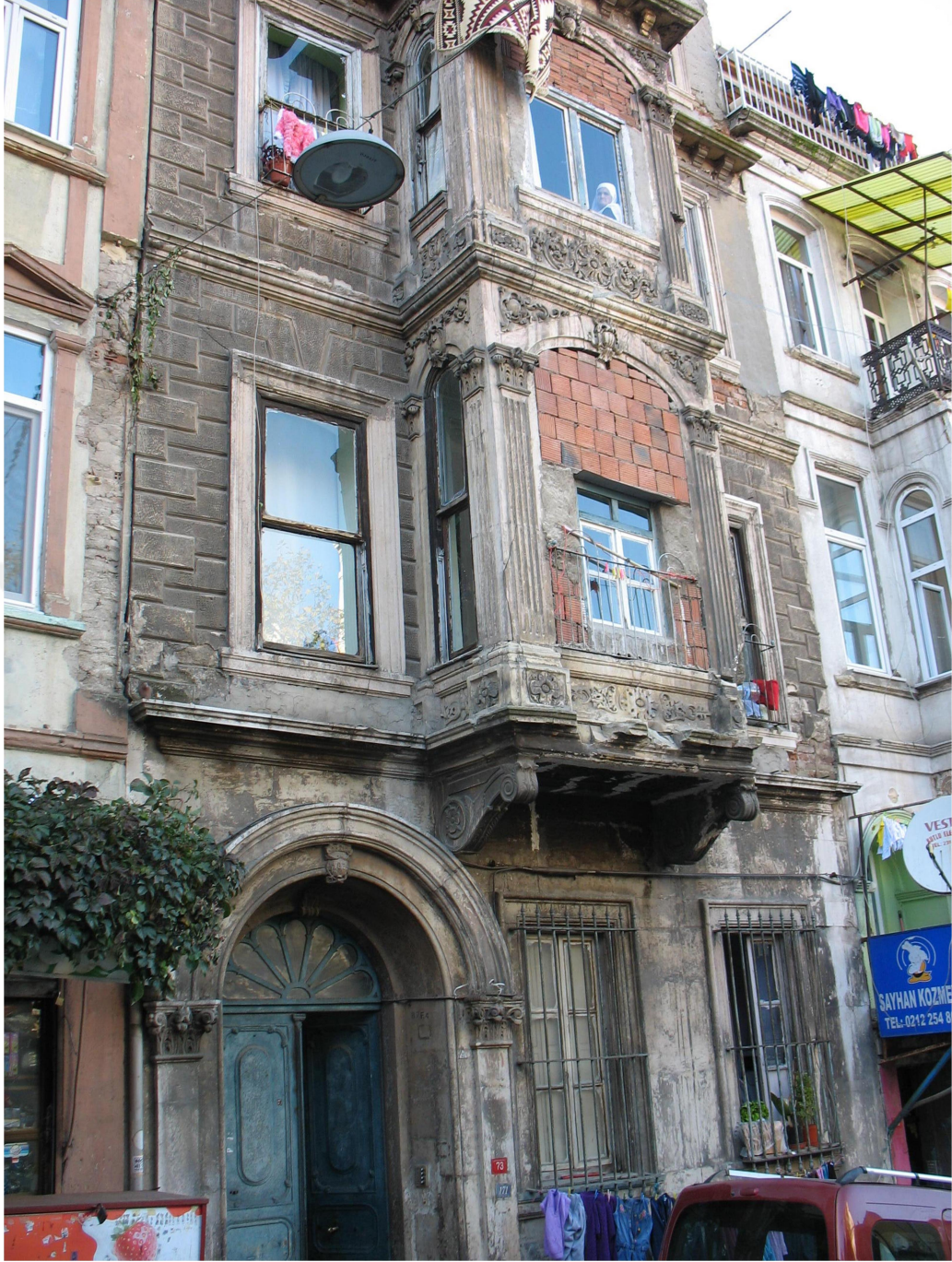
Şekil A.26 : 26 No'lu Eklektik Dönemi Binası
