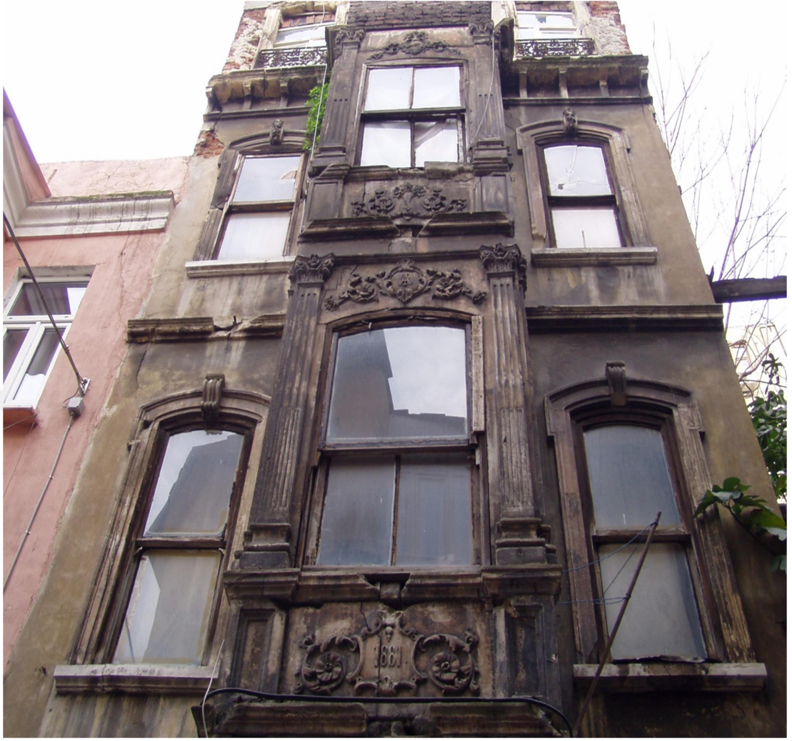
Şekil A.18 : 18 No’lu Eklektik Dönemi Binası
