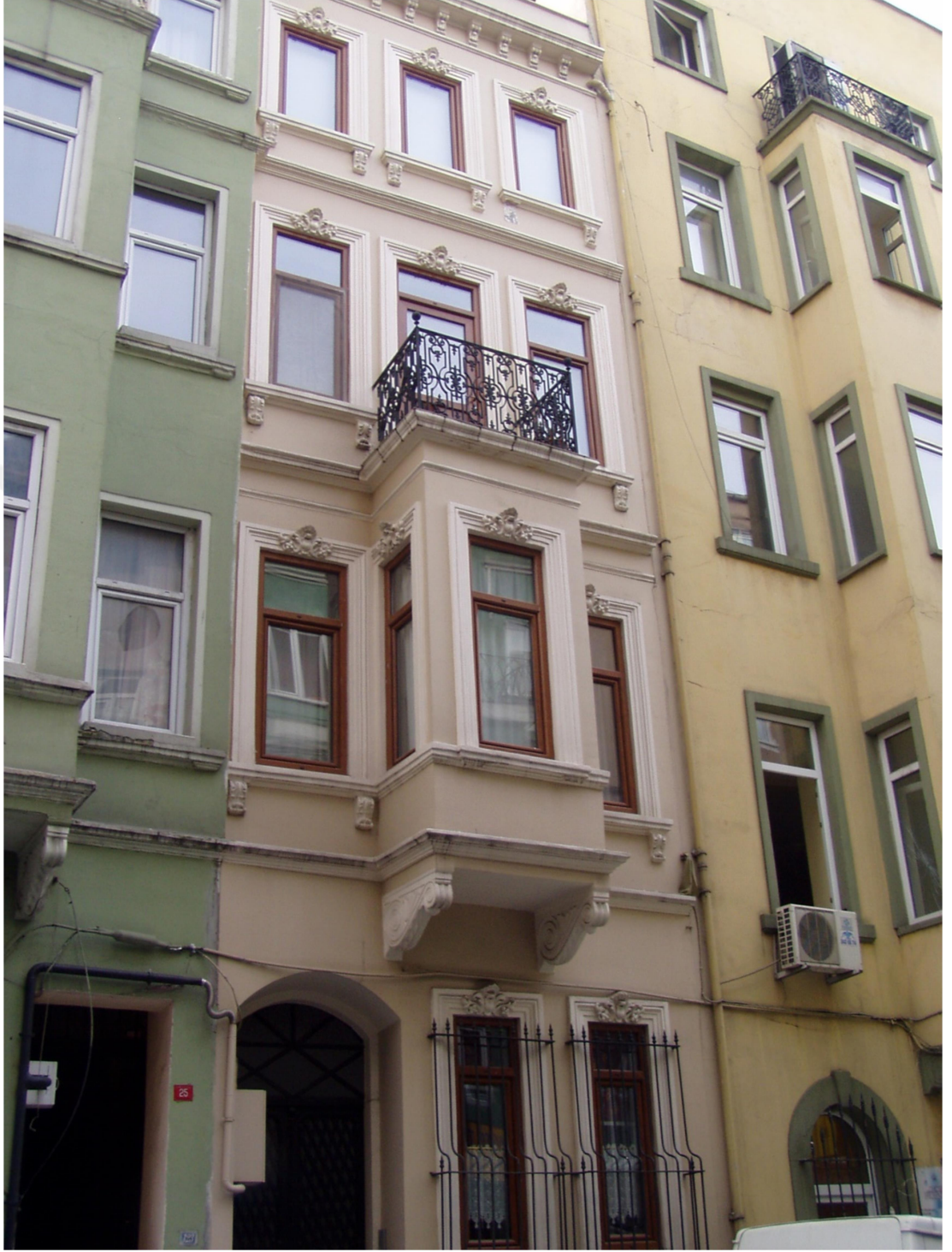
Şekil A.16 : 16 No'lu Eklektik Dönemi Binası
