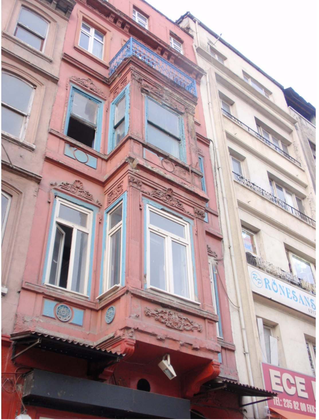
Şekil A.41: 41No’lu Eklektik Dönemi Binası
