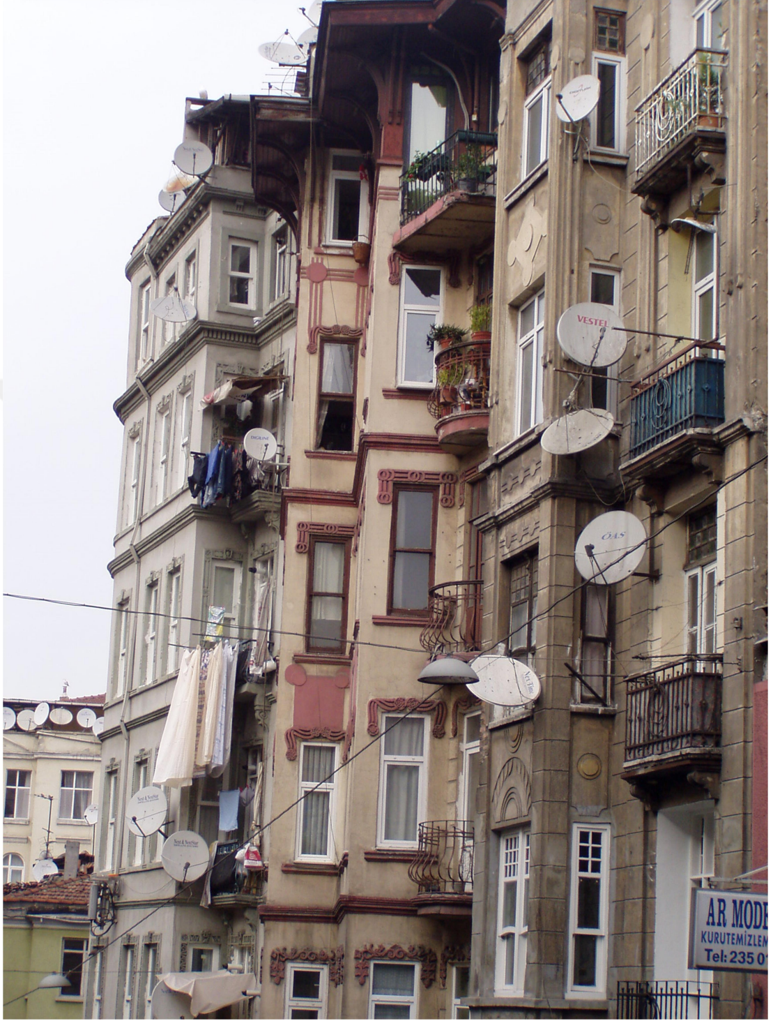
Şekil A.47: 47 No'lu Eklektik Dönemi Binası
