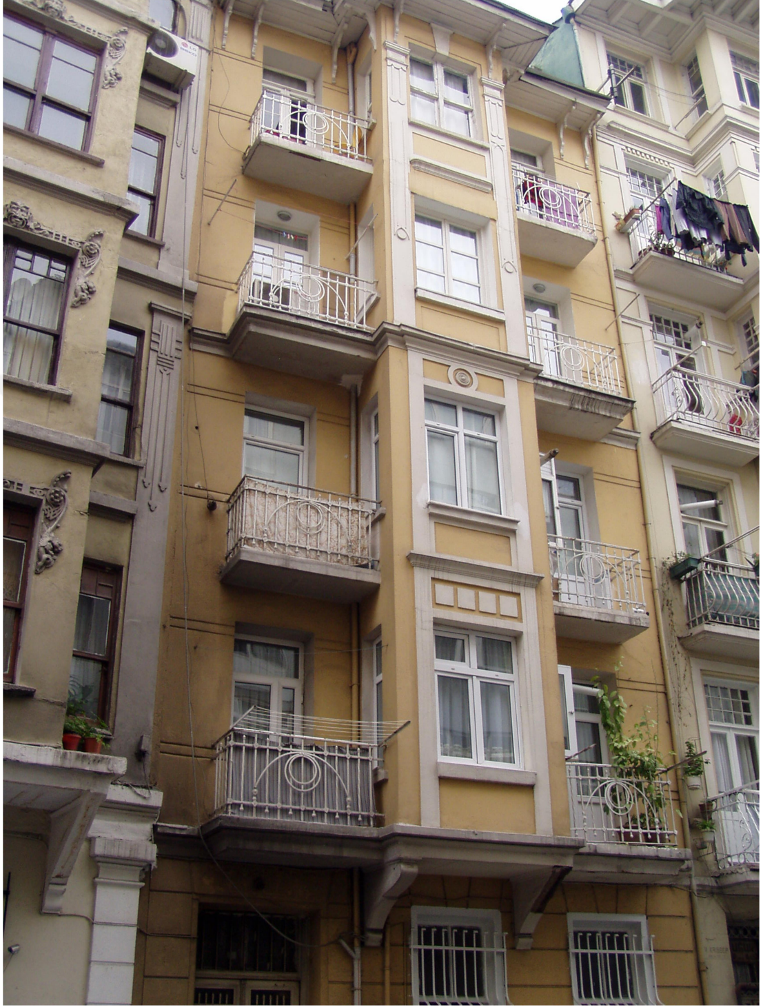
Şekil A.40: 40No'lu Eklektik Dönemi Binası
