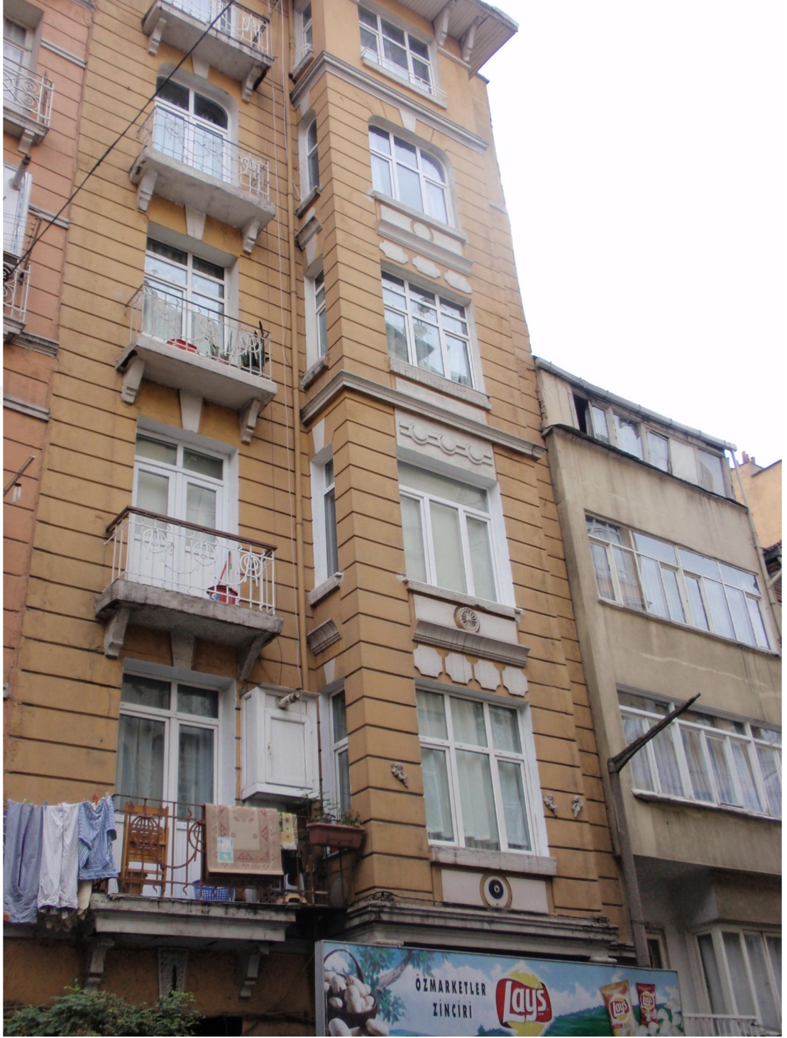
Şekil A.39: 39 No'lu Eklektik Dönemi Binası
