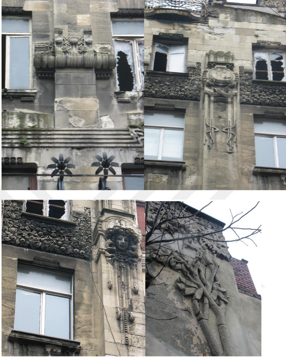
Şekil 2.2: Botter Apartmanı, Art Nouveau Dış Cephe Öğeleri
