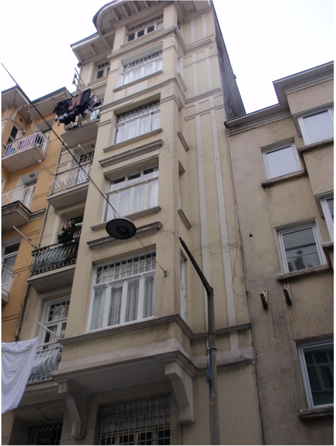
Şekil A.37: 37 No'lu Eklektik Dönemi Binası
