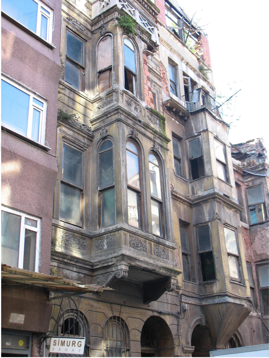
Şekil A.22 : 22 No'lu Eklektik Dönemi Binası
