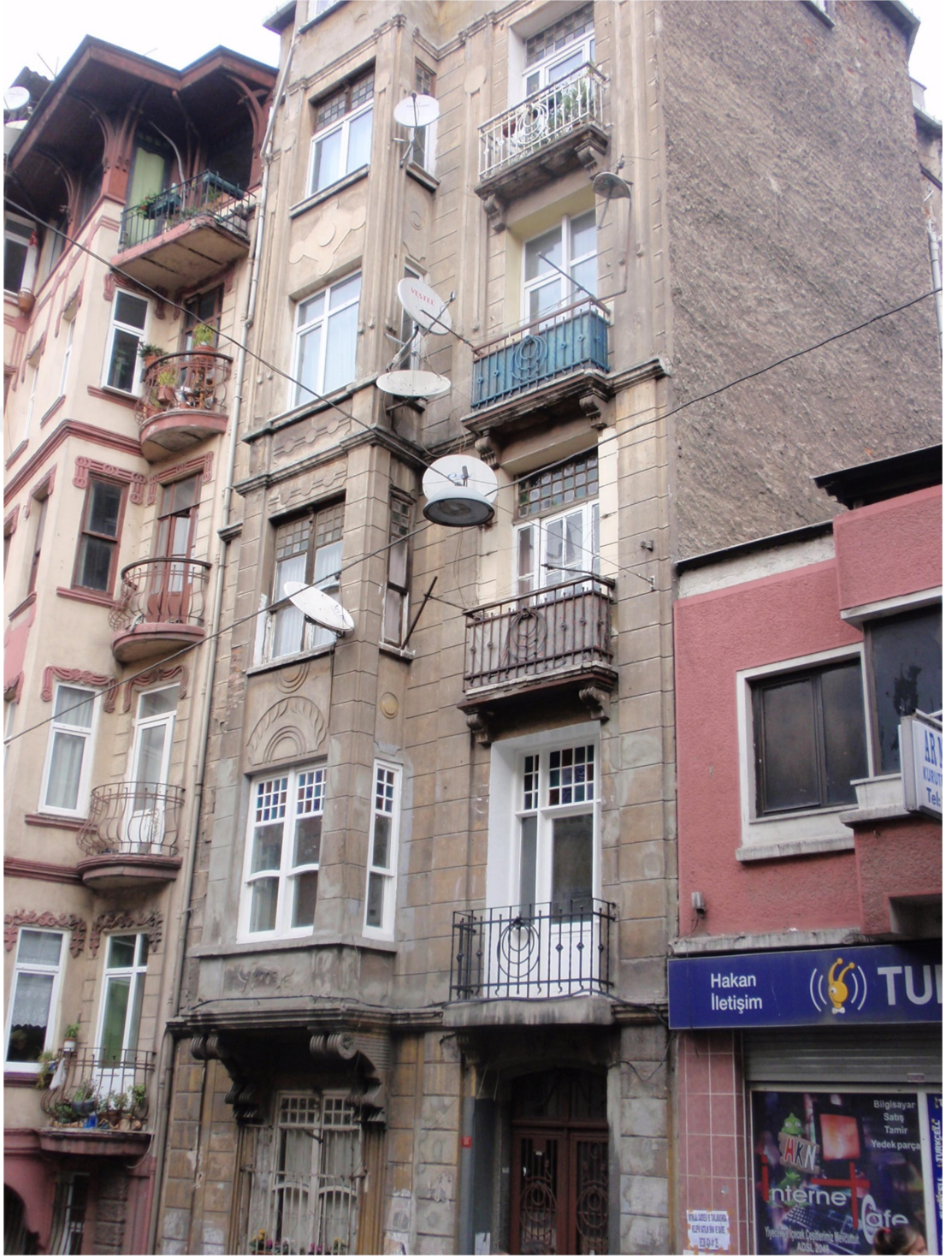
Şekil A.43: 43 No'lu Eklektik Dönemi Binası
