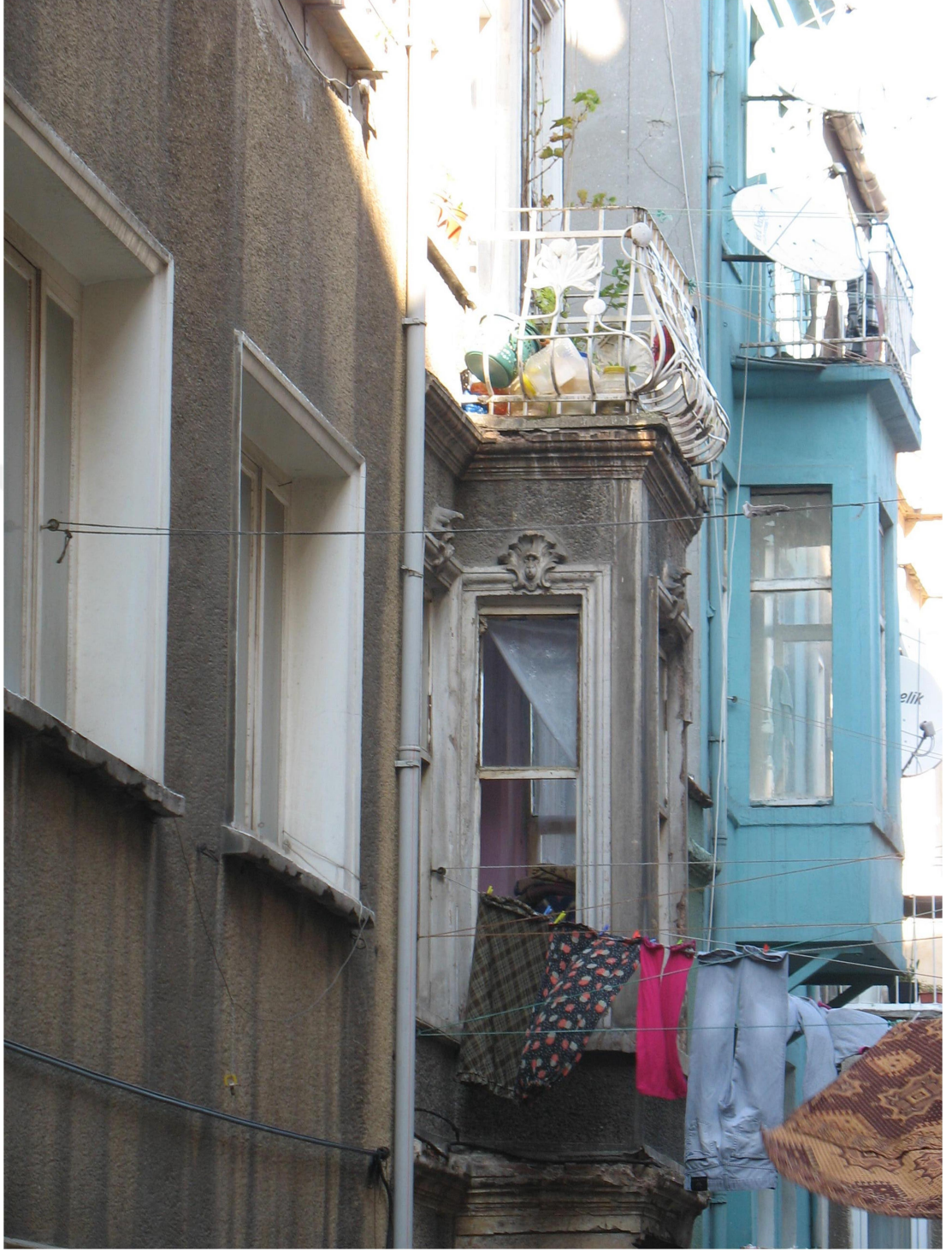
Şekil A.24 : 24 No'lu Eklektik Dönemi Binası
