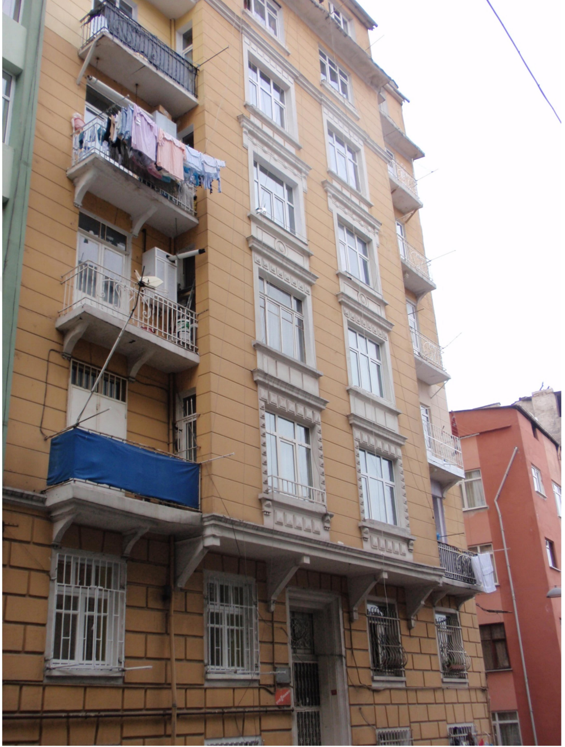
Şekil A.38: 38 No'lu Eklektik Dönemi Binası
