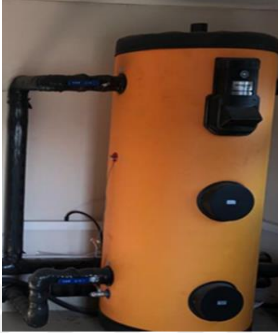
Şekil 4.20. Çift serpantinli akümülayon tankı
