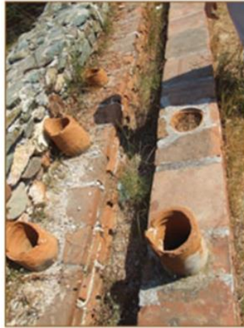
Şekil 2.2. Roma banyolarından Hypocaust kanalları kalıntısı (Bean vd., 2010b)
