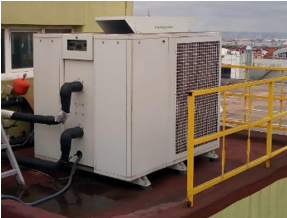
Şekil 4.12. Hava kaynaklı ısı pompası A/W 75 E
