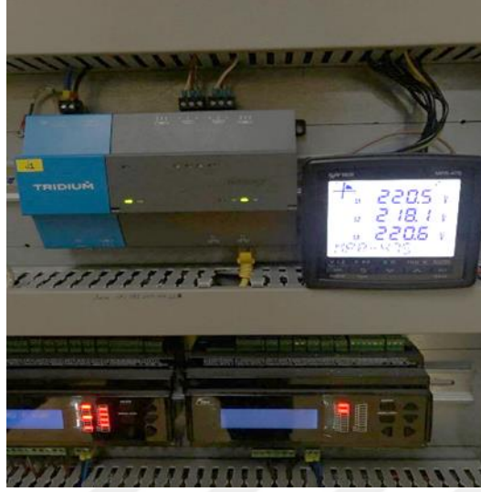
Şekil 4.28. Kullanılan kontrol sistemi ve güç analizörü
