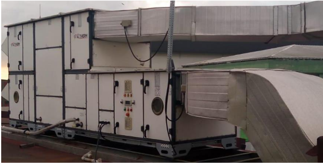
Şekil 4.11. Deneylerde kullanılan ısı geri kazanım santrali görseli
