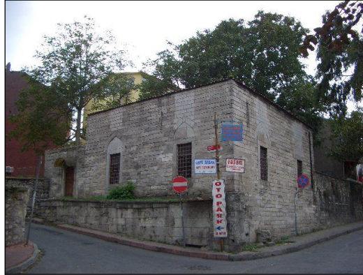
Şekil 4.118: Haseki Caddesi üzerinden İbrahim Paşa Sıbyan Mektebi'nin doğu cephesinin görünümü (Gökçe Ürk, 2010)
