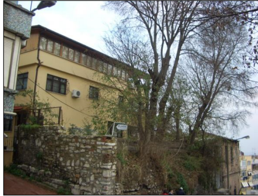
Şekil 4.125: Ahmet Paşa Sıbyan Mektebi'nin yanında bulunan mezarlık (Gökçe Ürk, 2009)
