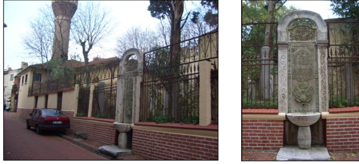
Şekil 4.129: 21 A kodlu, Cerrahpaşa Kazım Bey Çeşmesi (2390 ada, 29 parsel) (Gökçe Ürk, 2009)
