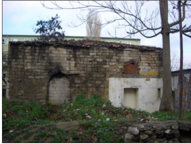
Şekil 4.120: İbrahim Paşa Sıbyan Mektebi'nin güney cephesinin görünümü (Gökçe Ürk, 2010)
