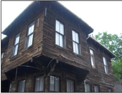
Şekil 4.159: Seyit Yakuphan Sokaktaki 56 S kodlu yapının konsol görünümü (Gökçe Ürk, 2010)
