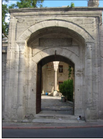
Şekil 4.81: Cerrah Paşa Külliyesi kuzey cephe yönündeki giriş cümle kapısı (Gökçe Ürk, 2010)
