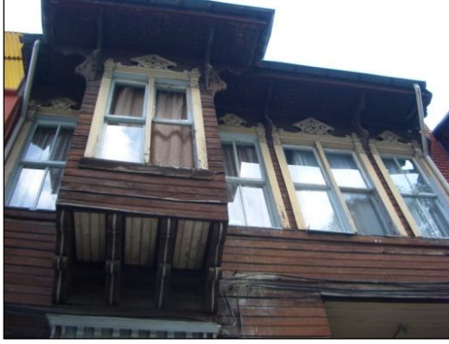
Şekil 4.158: Seyit Yakuphan Sokaktaki 59S kodlu yapının konsol görünümü (Gökçe Ürk, 2010)
