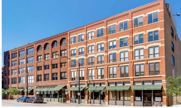
Şekil 3.3: Endüstri Yapısı örneği, 420W Grand Loft, Chicago (URL-6)
