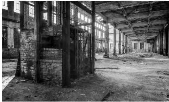
Şekil 3.13: Loft yapının yük asansörü, (Kasap;2004)
