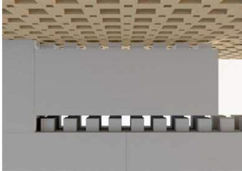
Şekil 4.21: NAWA bitiş tuğlasının üst kısmının monte edilmesi.
