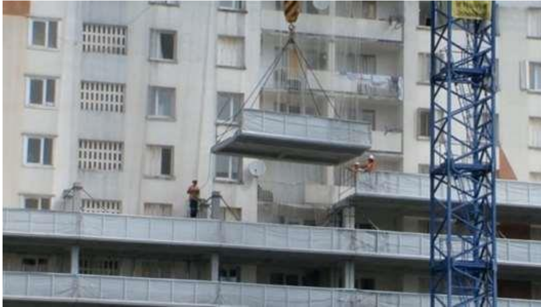
Şekil 2.26: G, H ve I bloklarının prefabrik modüller parçaları (URL13).
