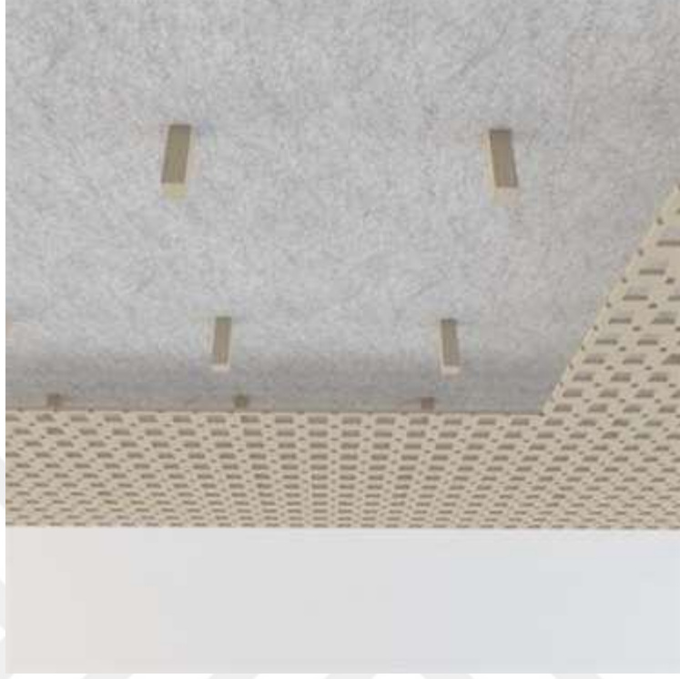
Şekil 4.18: NAWA için tavan ızgarasının kurulum aşamaları.
