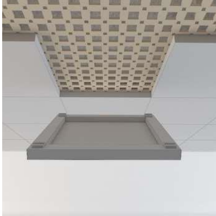
Şekil 4.28: NAWA asma tavan paneli monte edilmesi.
