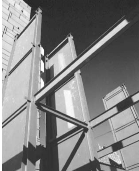
Şekil 1 Kanada’da çelik levha perdeli Canam Manac Genel Müdürlük ek binası.
