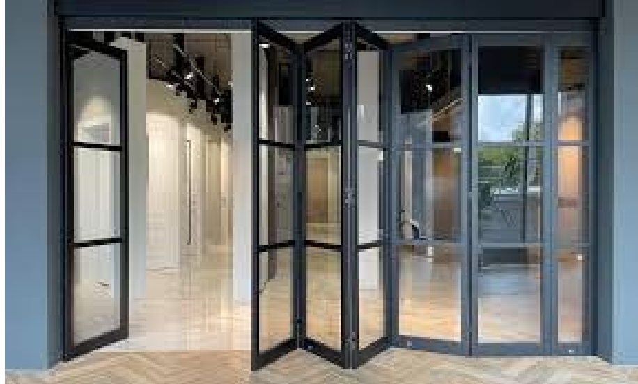
Şekil 4. 7. Döner Sistemli Ray Mekânizmalı Bölücü Eleman Örneği. (URL 28)
