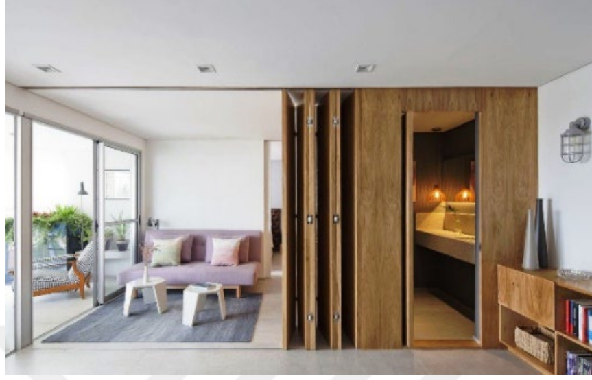
Şekil 3. 17. Ahşap Malzemeden Yapılmış Bölücü Eleman (URL 18).
