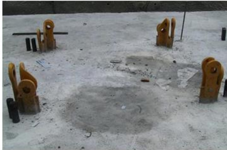
Resim 2.4: Betona Gömülü Ayak Sistemi
