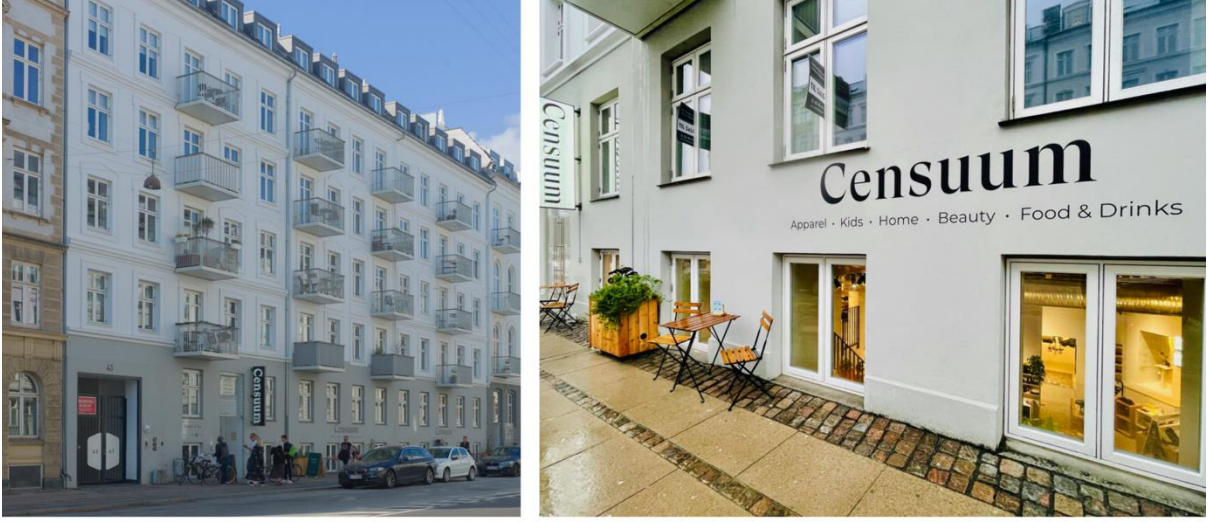
Görsel 4.38 Cephe görünümü (URL 55)
