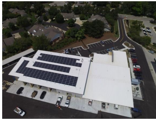
Şekil 5. 3. Çalışma Binasında Kullanılan Çatı Malzemesinin Görünümü (Url 19)
