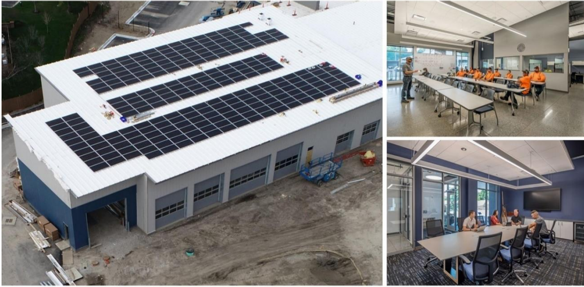
Şekil 5. 8. Çatıdaki Fotovoltaik Paneller (Soldaki Fotoğraf) Ve Tesisin Bazı Bölümlerindeki Enerji Verimli LED Aydınlatmalar (Sağdaki Fotoğraflar)
