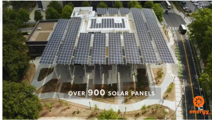
Şekil 5. 30. Georgia Tech'te Kendeda Binasının Çatısında Bulunan Yaklaşık 900 ün Üzerinde Güneş Panelleri (Url 26)
