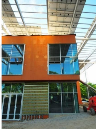
Şekil 5. 31. Georgia Tech'te Kendeda Binasının Çatısına Yaklaşık 917 Güneş Panelinin Kurulum Aşaması (Url 26).
