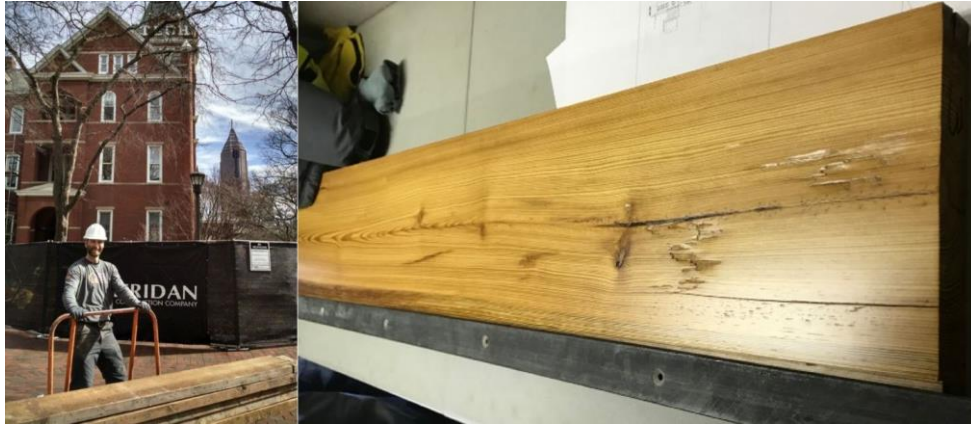
Şekil 5. 35. Tech Tower'ın 1880'lerden kalma Çam Kirişlerin Kendeda Binası İçin Merdiven Basamakları Olarak Yeniden Kullanılmasına Yönelik Çalışmalar (Url 26)
