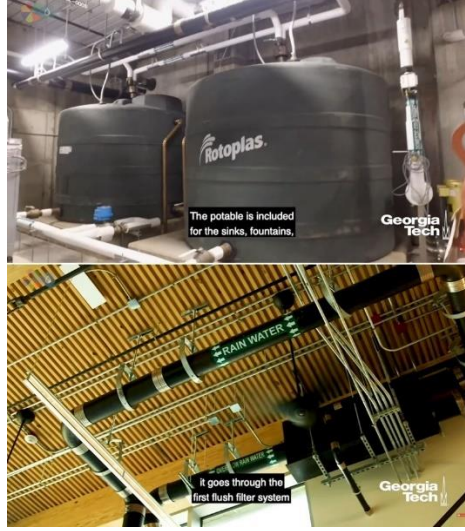
Şekil 5. 27. Georgia Tech'te Yağmur Suyu Arıtma Sistemlerinin Bir Bölümü (Url 26).
