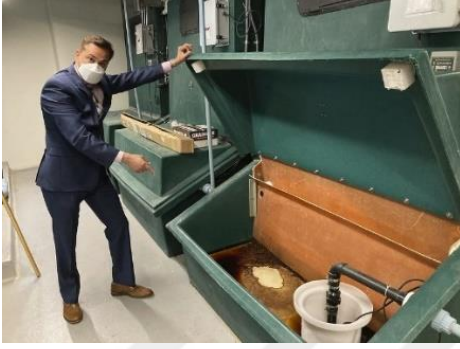
Şekil 5. 53. Binanın Bodrum Katında Bulunan Kompostlama Makineleri
