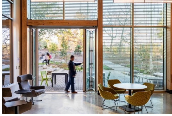
Şekil 5. 32. Kendeda Binası'ndaki Katlanır Cam Kapılar (Url 29)
