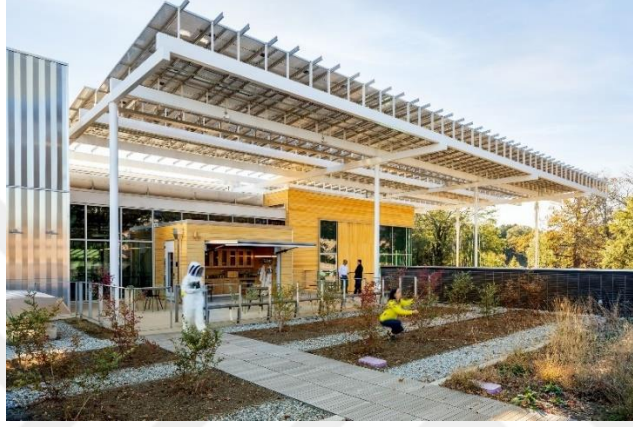
Şekil 5. 21. Georgia Tech'te Kentsel Tarım: Çatı Bahçesi (Url 26)
