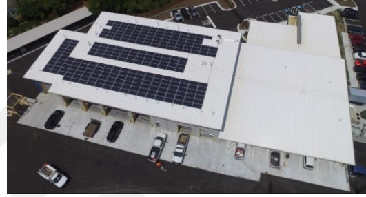
Şekil 5. 46. PW Tesisinde Açık Renkli Çatı Malzemesi
