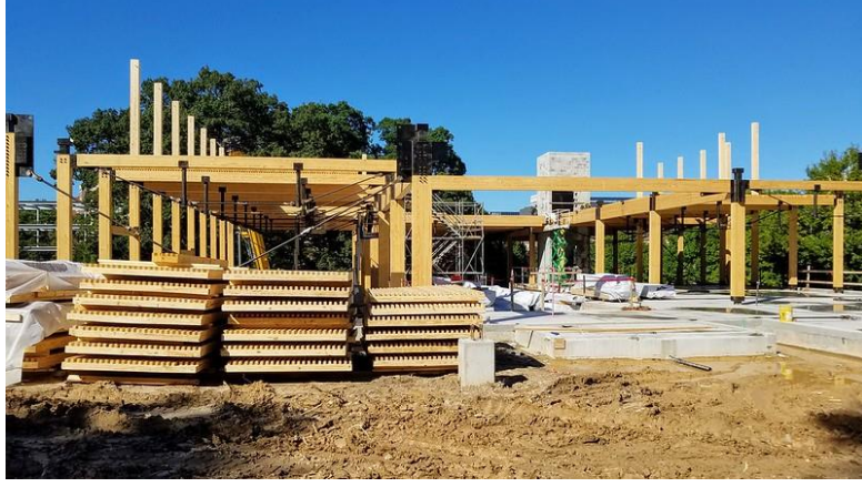
Şekil 5. 29. Kendeda Binasının Ahşap Konstrüksiyon İle Yapım Aşaması (Url 29)
