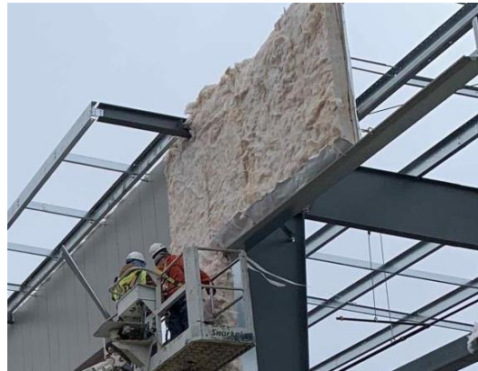
Şekil 5. 11. Tesisteki Düşük Emisyonlu Yalıtım Malzemelerinin Montelenme Aşaması
