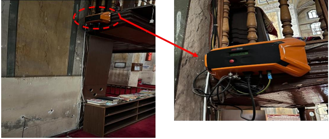
Şekil 3.5. Kapiler nem itme cihazının montajı (Yazarın kendi resimlendirmesidir.)
