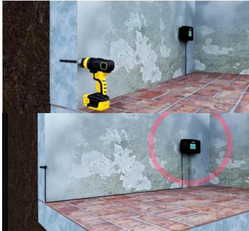
Şekil 2.9. Kapiler nem itme cihazının kurulumunun ilk aşaması (URL-1)
