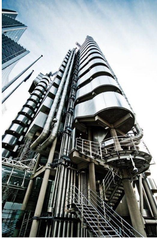
Resim 11. Lloyd Binası, Londra (URL-9)
