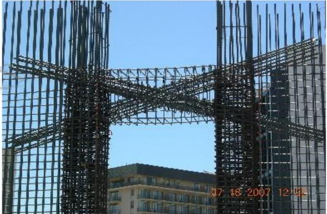
Şekil 3.2: Betonarme bağ kirişinin donatı uygulaması (Sowmya ve Chandra, 2014).
