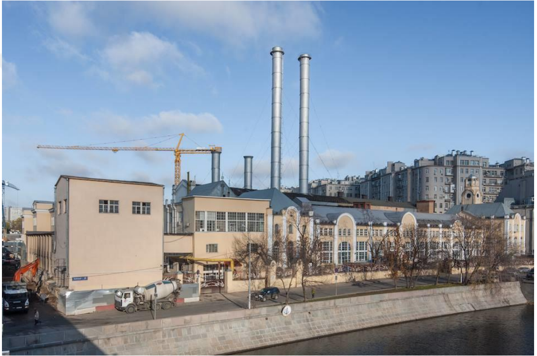
Şekil 2.16 Moskova Elektrik Santrali'nin restorasyondan önceki hali (Url-10).
