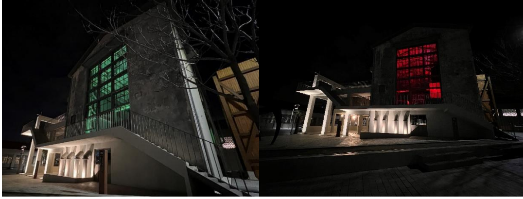
Şekil 4.9 S Binasının; RGB ışık ile cephede geçen ışıklık tekniği kullanılması, betonarme kolonların vurgu aydınlatma ile aydınlatılması (Öztütüncü, 2021).
