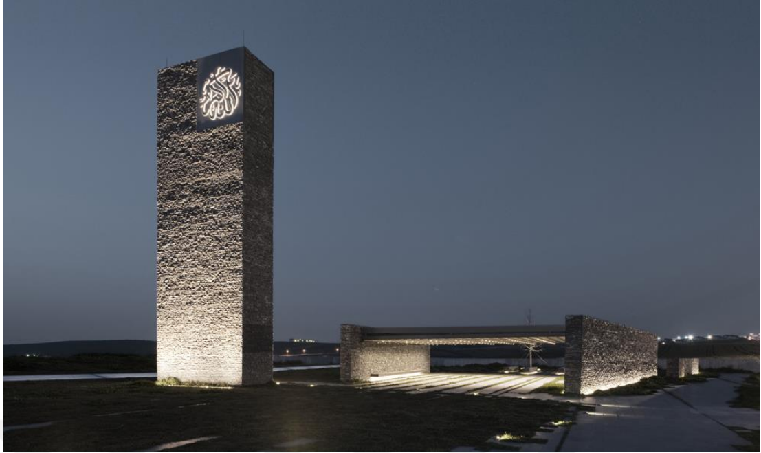
Şekil 3.7 Dikkat çeken aydınlatma, Sancaklar Camii, Studio Lighting Design (Url-34).
