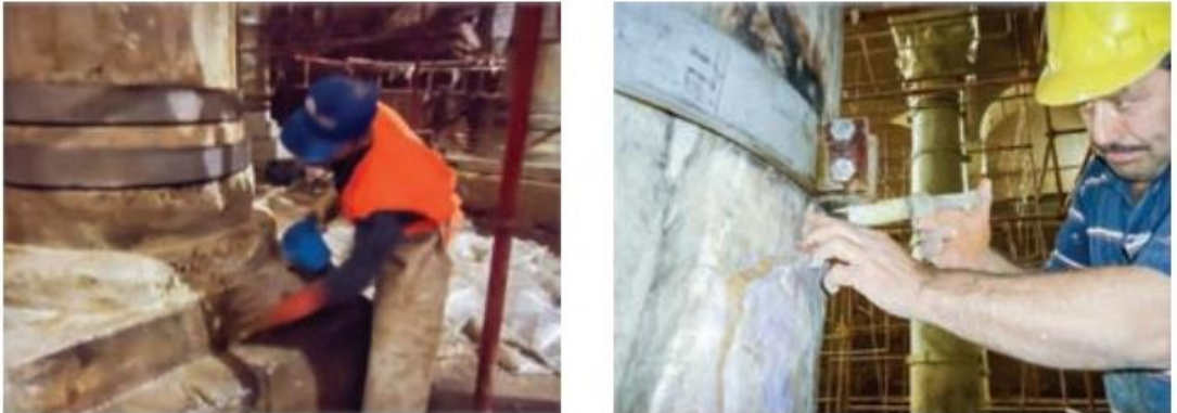
Şekil 2.2 Temizlik uygulaması ve sağlamlaştırma çalışması (İBB,2016).
