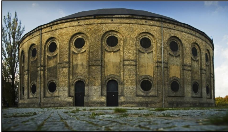
Şekil 2.35 Østre Gasværk Tiyatrosu dış görünüşü (Url-28) (Erişim Tarihi 21.10.2021).
