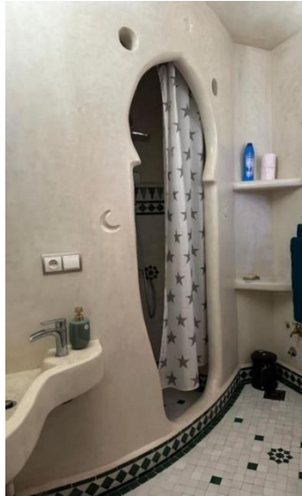
Şekil 4. 113. Banyoda tadelakt duvar kaplaması ve zellige zemin uygulaması (Yazar tarafından çekilmiştir)
