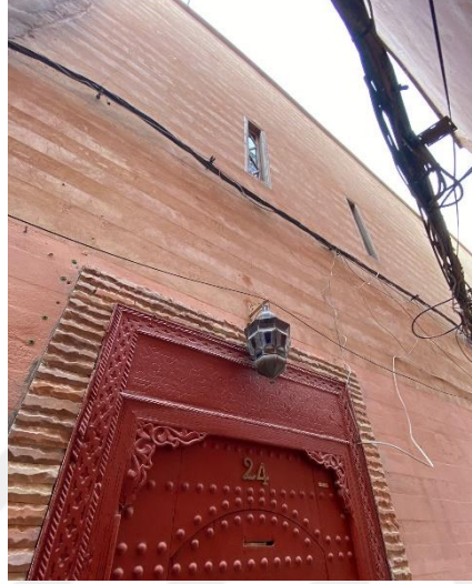
Şekil 4. 39. Dar Tesali dış cephesi (Yazar tarafından çekilmiştir)
