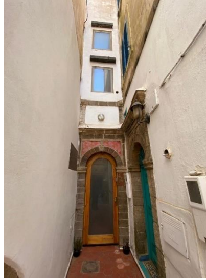
Şekil 4. 100. Ouymi Evi'nin dış cephesi (Yazar tarafından çekilmiştir)
