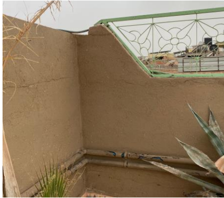
Şekil 4. 15. Dış duvarlarda kullanılan saman katkılı toprak sıva (Yazar tarafından çekilmiştir)
