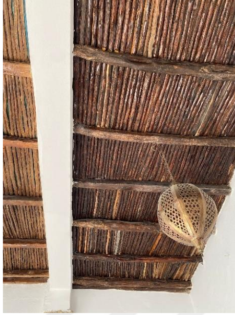
Şekil 4. 139. Yerel malzemelerden tavan uygulaması (Yazar tarafından çekilmiştir)
