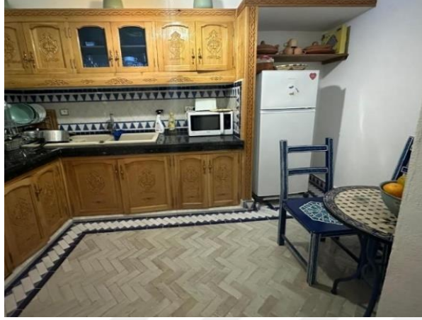
Şekil 4. 114. Mutfak zemininde bejmat malzemesi (Yazar tarafından çekilmiştir)
