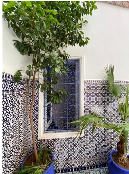
Şekil 4. 137. Duvardaki tadelakt ve zellige malzemeleri (Yazar tarafından çekilmiştir)
