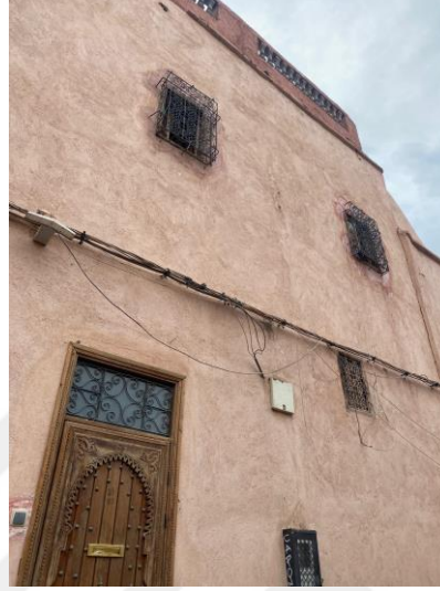
Şekil 4. 69. Dar Tamri'nin dış cephesi (Yazar tarafından çekilmiştir)
