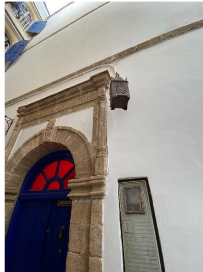
Şekil 4. 122. Dar Bouchra'nın dış cephesi (Yazar tarafından çekilmiştir)
