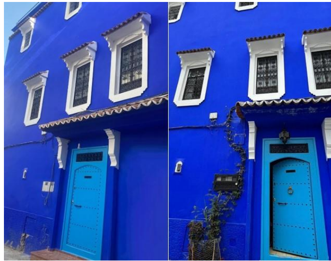
Şekil 4. 87. Watis Evi'nin dış cephesi (Yazar tarafından çekilmiştir)
