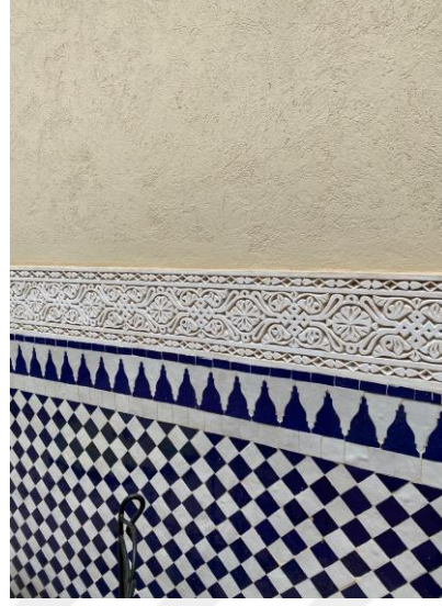
řekil 4. 59. Duvardaki Jibs ve Zellige malzemeleri (Yazar tarafından ekilmiřtir)
