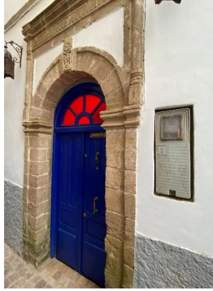
Şekil 4. 123. Dar Bouchra'nın giriş kapısı (Yazar tarafından çekilmiştir)
