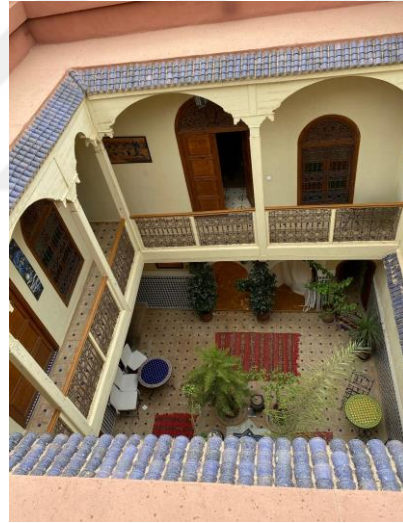
Şekil 4. 62. Çatı kenarında kiremit (Yazar tarafından çekilmiştir)
