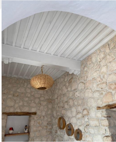
Şekil 4. 105. Odadaki kireçtaşı duvar (Yazar tarafından çekilmiştir)
