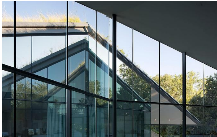
Şekil 39. Edgeland House renkli ve vakumlu cam paneller (URL-45)
