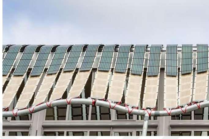
Şekil 27. Soft House hareketli fotovoltaik paneller (URL-23)
