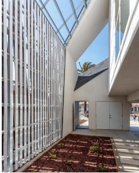
Şekil 34. IVRV House TiO 2 ile kaplanmış şeritler (URL-36)
