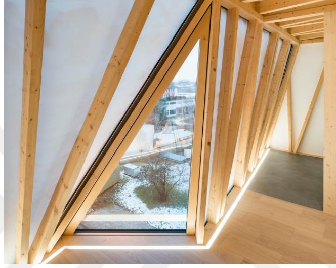
Şekil 44. DFAB House LED aydınlatma (URL-55)
