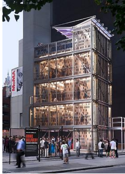
Şekil 29. Cellophane House genel görünüm (URL-27)
