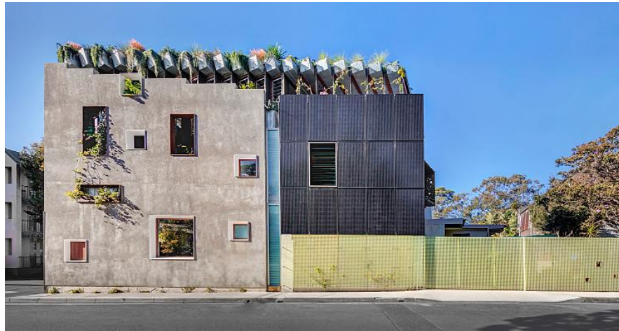
Şekil 42. The Jungle House cephede fotovoltaik panel kullanımı (URL-51)
