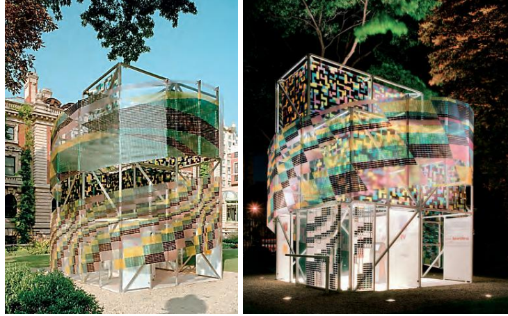
Şekil 19. Organik ışık yayan diyotlar (OLED) ile oluşturulmuş cephe yüzeyi, Smartwrap, Ritter (2007)
