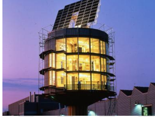
Şekil 20. Çatıya entegre edilen fotovoltaik paneller, The Heliotrop, Rolf Disch (1994) (URL-10)
