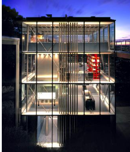
Şekil 21. House R 128 cephedeki ısı depolayan camlar (URL-11)
