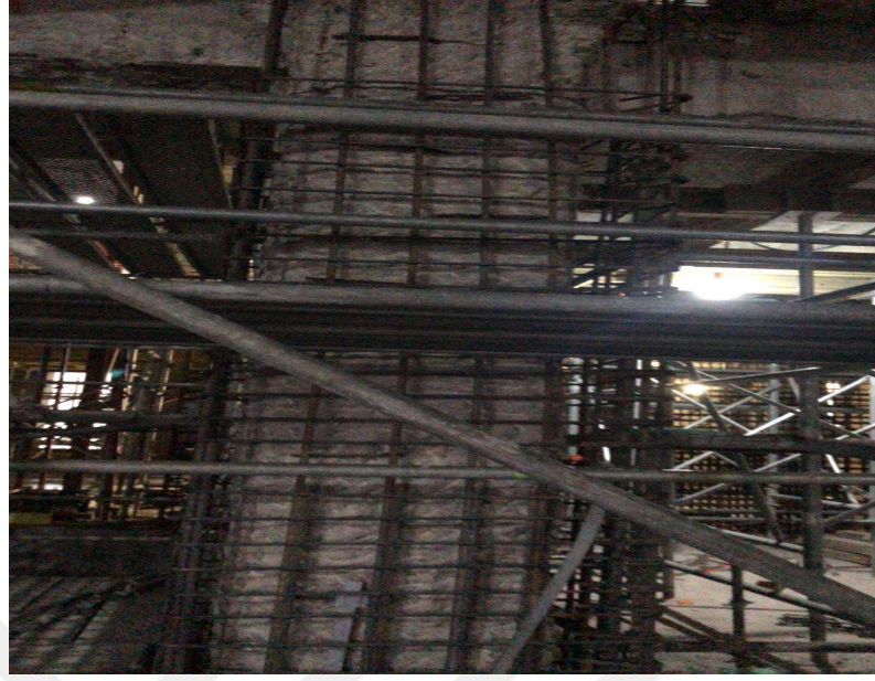
Şekil 3.2: Kolon Mantolama Uygulaması
