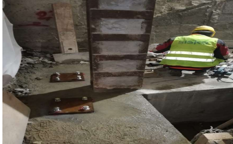
Şekil 3.3: Çelik Sargı Uygulaması
