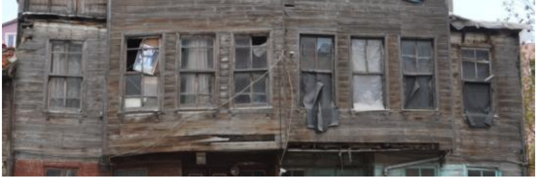
Şekil 4-134 15 ve 17 No'lu Yapı 1. Kat Pencereleeri
