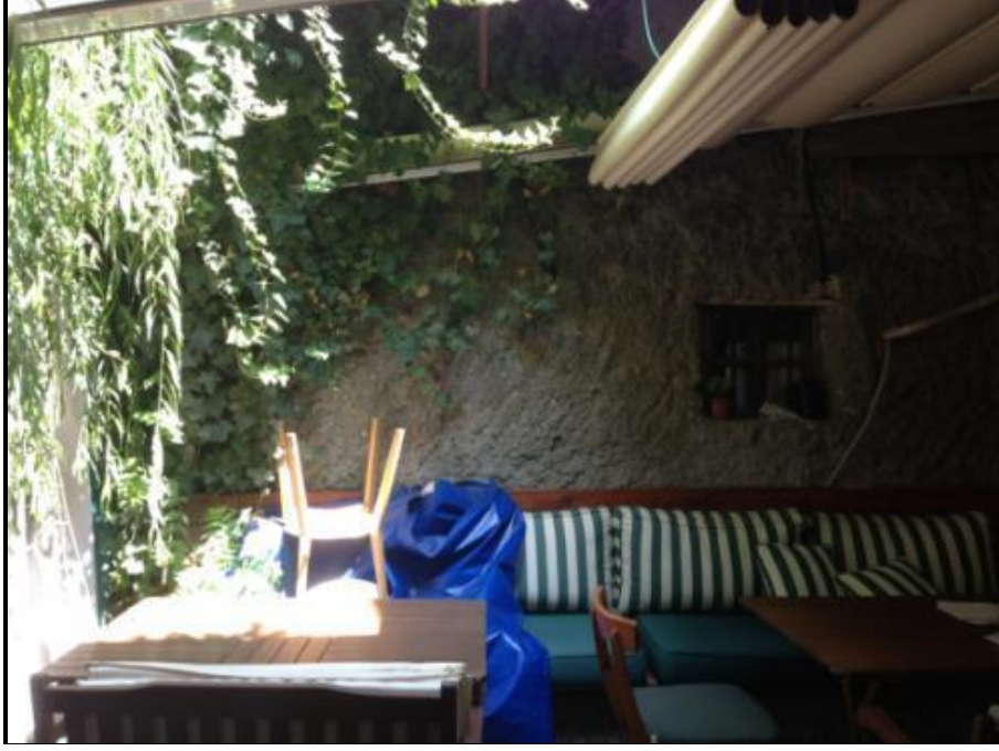
Şekil 4-72 B/2-06 Bahçe, 9 No'lu Komşu Yapıya Ek Yapı (Şık, Tekirdağ, 2012)
