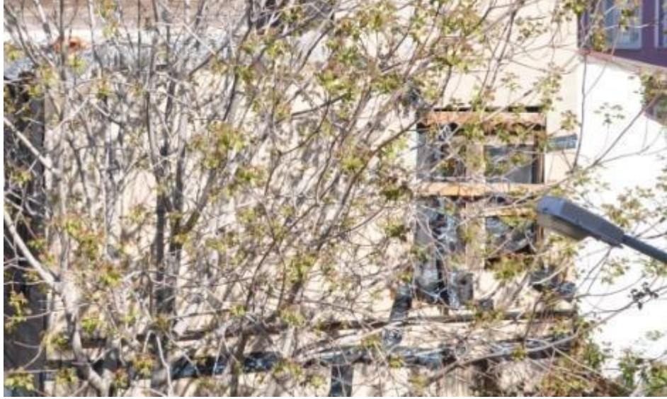
Şekil 4-143 17 No'lu Yapının Batı Cephesindeki 1. Kat Pencere Boşluğu
