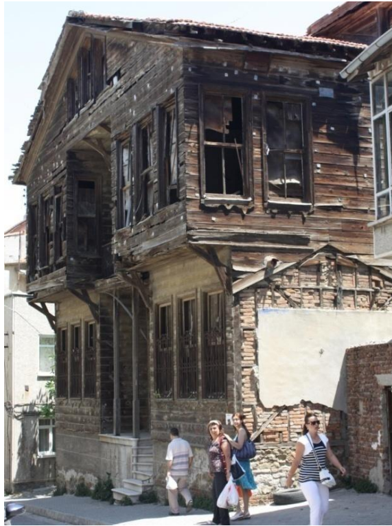
Şekil 3-25 Soğukkuyu Cad. 97ada, 17 parsel (Şık, Tekirdağ, 2012)
