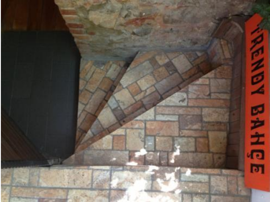
Şekil 4-64 B/2-04 Bahçeye çıkan merdivenler, 17 No'lu Yapıya Ek Yapı (Şık, Tekirdağ, 2012)
