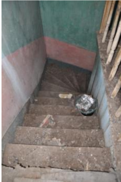
Şekil 4-38 1. Kattan 2. Kata Çıkan Merdivenler (Şık, Tekirdağ, 2012)
