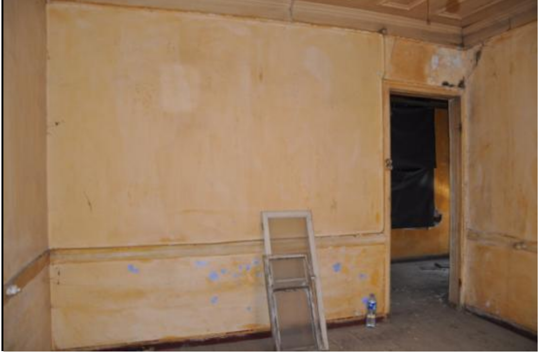
Şekil 4-100 1/2-03 Oda, Güney Duvarı (Şık, Tekirdağ, 2012)
