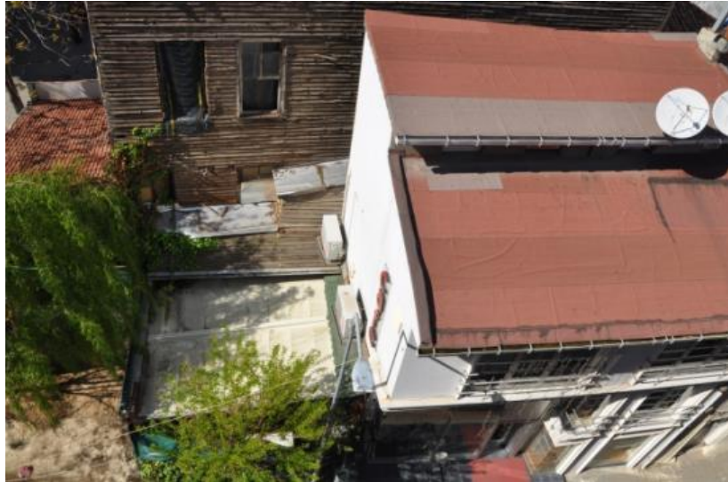
Şekil 4-146 15 ve 17 No'lu Yapıya Komşu 9 No'lu Yapı ve 9 No'lu Yapıya Ek Sundurma (Şık, Tekirdağ, 2012)
