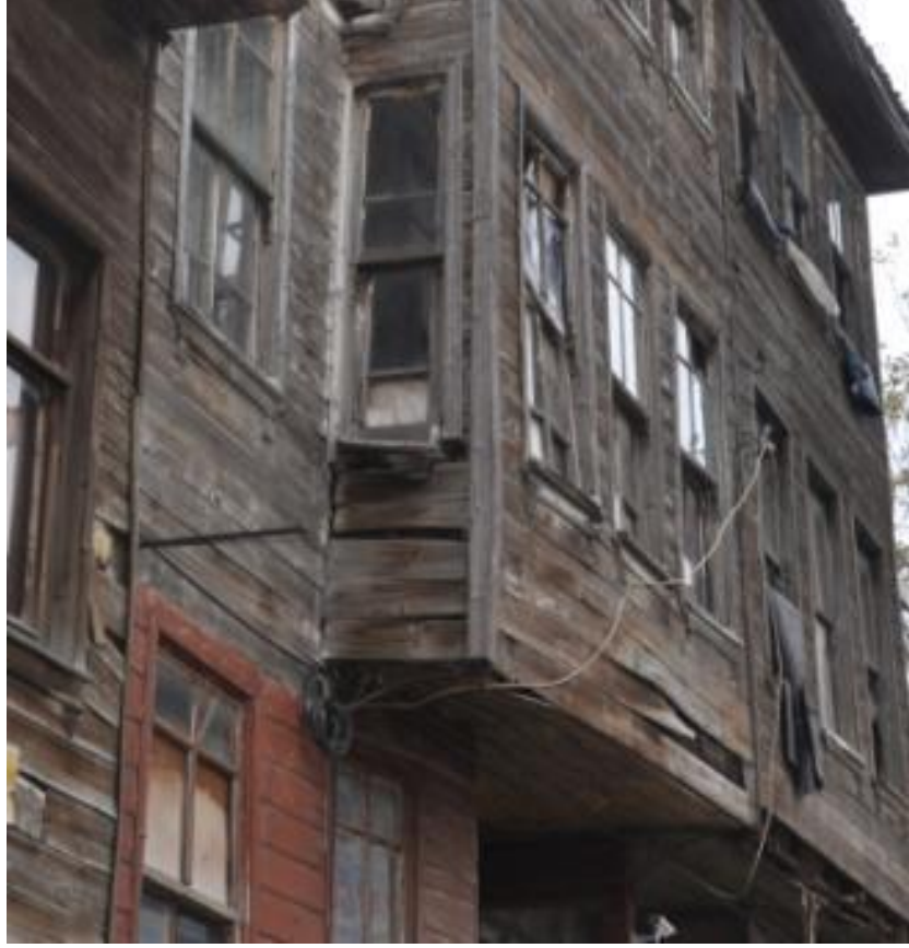
Şekil 4-132 1/1-03 Odasının Kuzey ve Doğu Cephesindeki Pencereleler (Şık, Tekirdağ, 2012)
