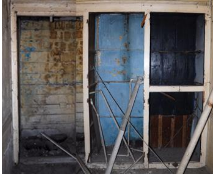
Şekil 3-16 Yüklük, Ertuğrul Mahallesi, Sefa Sokak, 309 Ada-2 Parsel (Şık, Tekirdağ, 2012)
