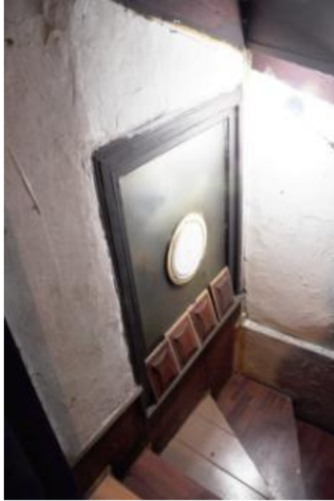
Şekil 4-10 Merdivendeki Pencere, Bodrum Kattan 1. Kata Çıkan Ahşap Merdivenler (Şık, Tekirdağ, 2012)
