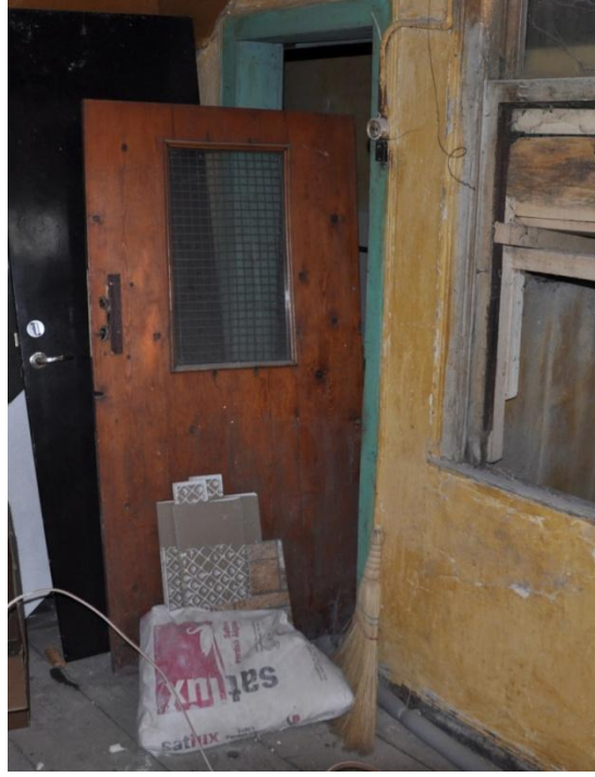
Şekil 5-5 numaralı yapıya ek Z/2-05 mutfak girişi (Şık, Tekirdağ, 2012)
