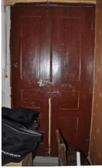
Şekil 4-12 Z/1-01 Giriş Holü Kapısı (Şık, Tekirdağ, 2012)
