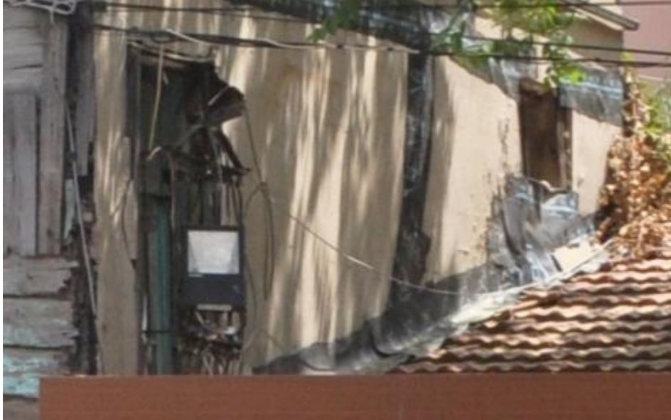
Şekil 4-142 17 No'lu Yapının Batı Cephesindeki Zemin Kat Pencereleri
