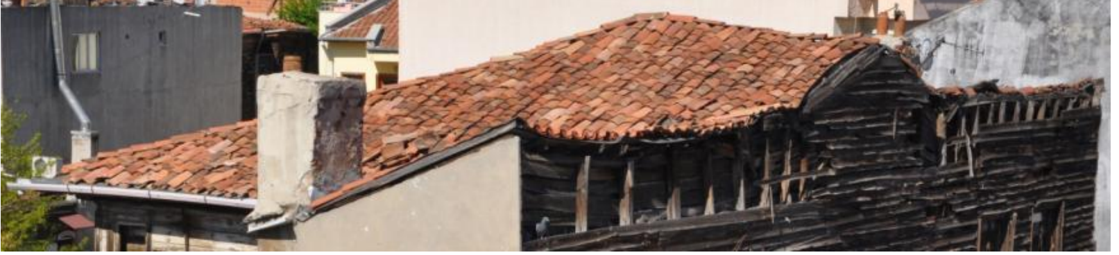
Şekil 4-154 15 ve 17 No'lu Yapının Çatı Örtüsü (Şık, Tekirdağ, 2012)
