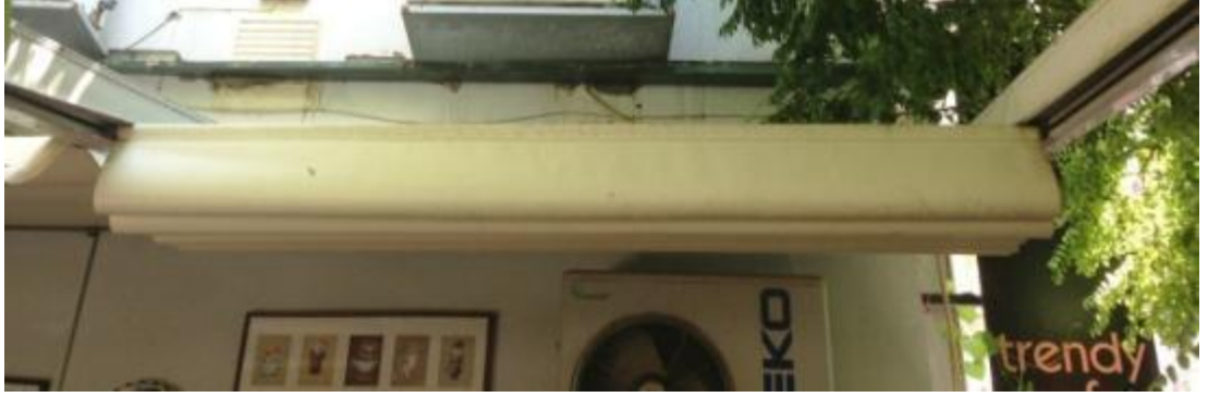
Şekil 4-149 9 No'lu Yapıya Ek Sundurmanın Çatı Örtüsü (Şık, Tekirdağ, 2012)
