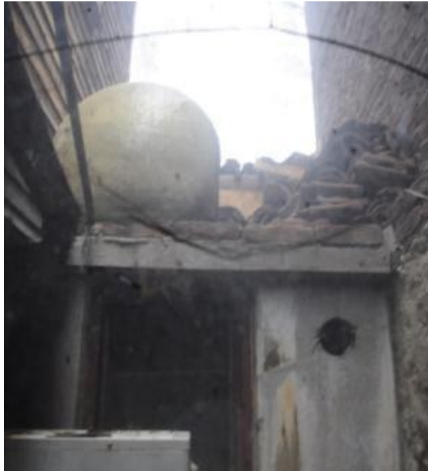
Şekil 4-150 15 No'lu Yapıya ek olan deponun batıya bakan penceresi (Şık, Tekirdağ, 2012)
