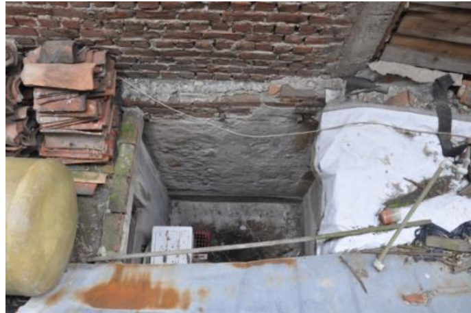
Şekil 4-27 Ardiye ve Depo arasındaki boşluk, Zemin Kat (Şık, Tekirdağ, 2012)
