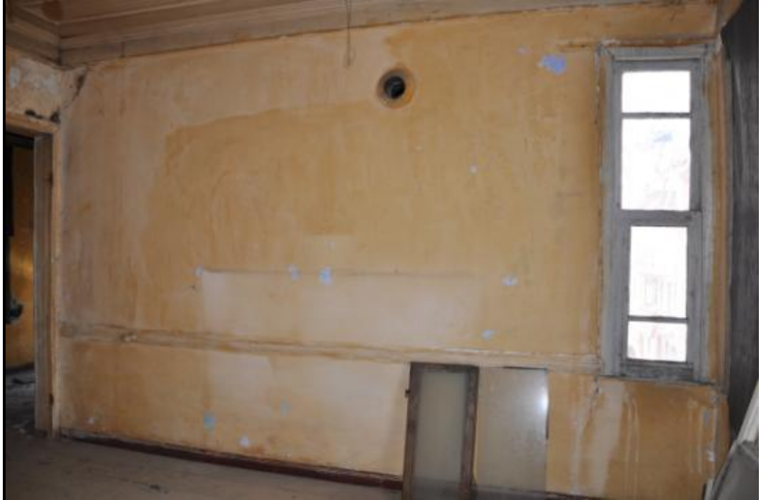
Şekil 4-102 1/2-03 Oda, Batı Duvarı (Şık, Tekirdağ, 2012)
