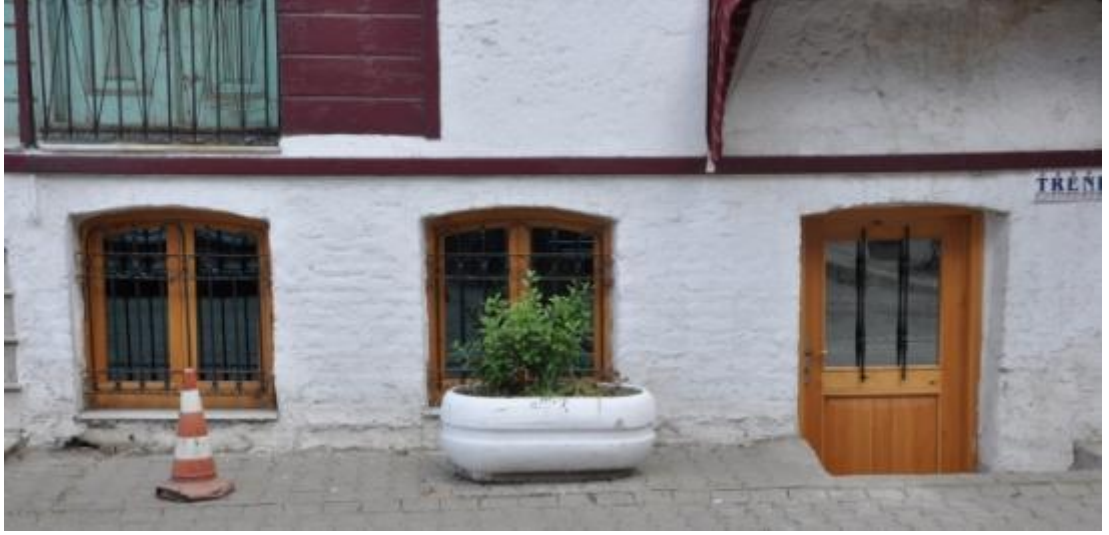
Şekil 4-48 Kuzey Cephesi, B/2-01 Kafeterya Giriş Kapısı (Şık, Tekirdağ, 2012)
