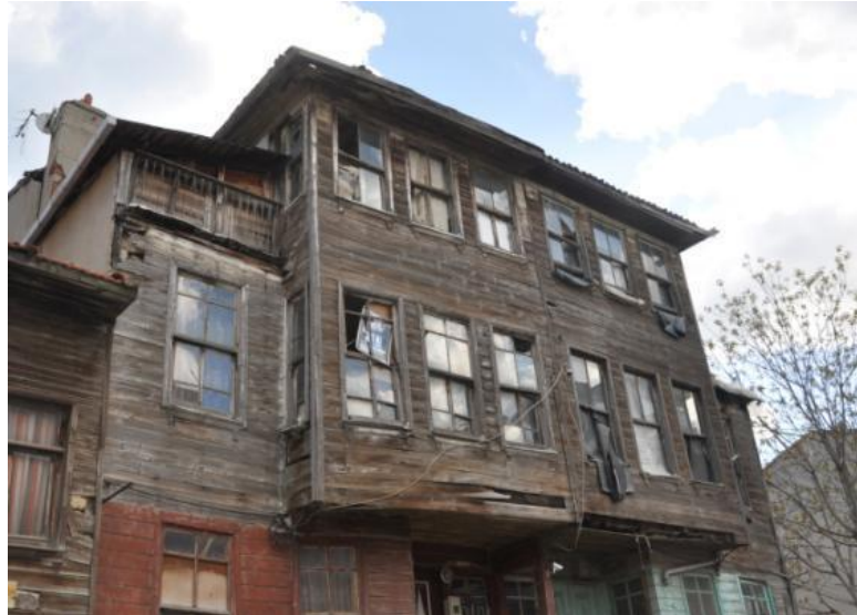
Şekil 4-130 15 ve 17 No'lu Yapı Kuzey Cephesindeki Çıkma (Şık, Tekirdağ, 2012)
