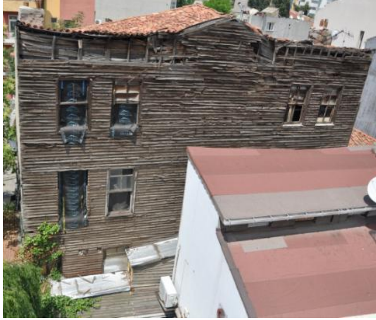
Şekil 4-145 15 No'lu ve 17 No'lu Yapının Güney Cephesi (Şık, Tekirdağ, 2012)
