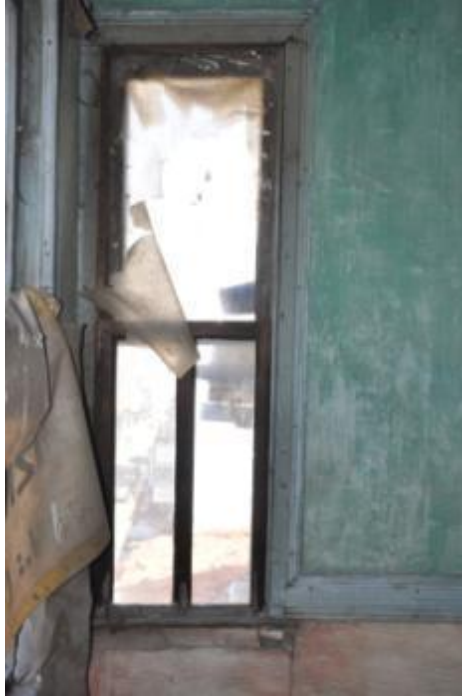
Şekil 4-46 2/1-03 Başoda, Kuzeydoğuya Bakan Pencere (Şık, Tekirdağ, 2012)
