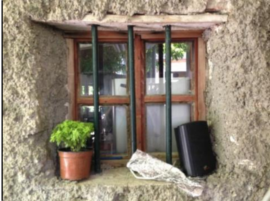
Şekil 4-73 B/2-06 Bahçe,Kuzey duvarındaki pencere, 9 No'lu Komşu Yapıya Ek Yapı (Şık, Tekirdağ, 2012)
