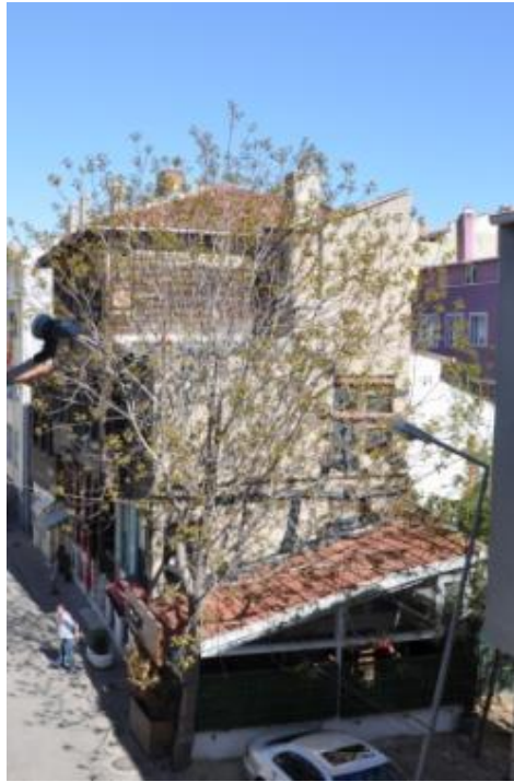
Şekil 4-120 17 No'lu Yapı – Batı Cephesi - Eski Bedesten Sokak (Şık, Tekirdağ, 2012)
