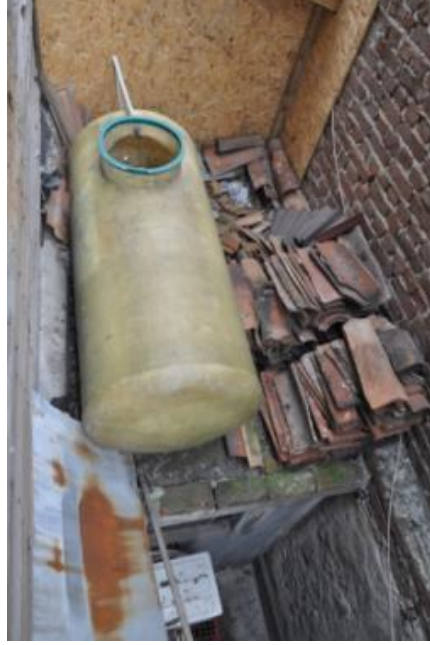
Şekil 4-26 Deponun Çatısı, Zemin Kat (Şık, Tekirdağ, 2012)
