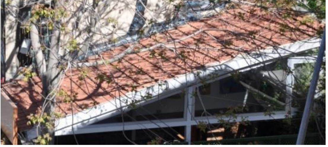
Şekil 4-141 17 No'lu Yapıya Ek Yapı - Sundurmanın Çatısı (Şık, Tekirdağ, 2012)
