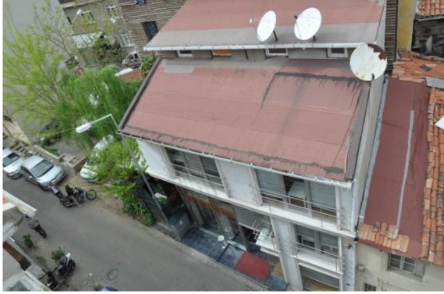
Şekil 4-121 15 ve 17 No'lu İkiz Yapı – Güney Cephesi - Eski Bedesten Sokak (Şık, Tekirdağ, 2012)
