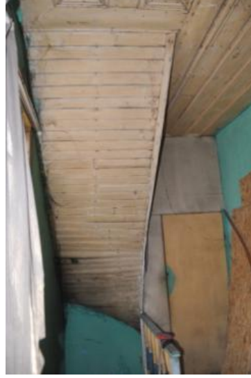
Şekil 4-31 1/1-01, 1. Kattan 2. Kata Çıkan Merdivenler (Şık, Tekirdağ, 2012)
