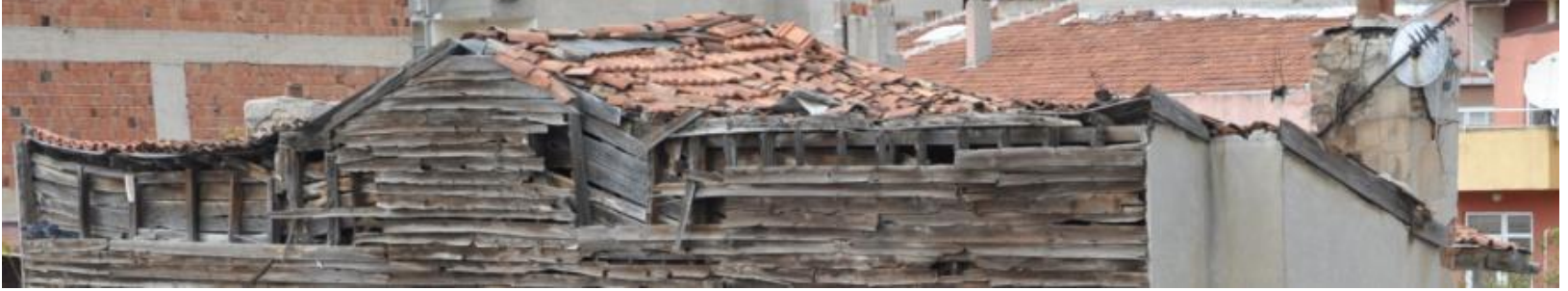
Şekil 4-155 15 ve 17 No'lu Yapının Çatı Örtüsü (Şık, Tekirdağ, 2012)
