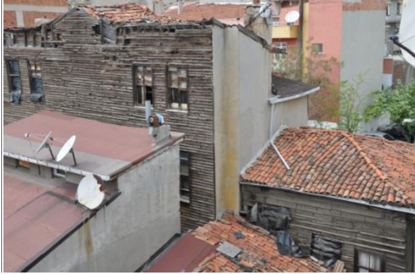
Şekil 4-119 17 No'lu Yapı – Doğu Cephesi (Şık, Tekirdağ, 2012)
