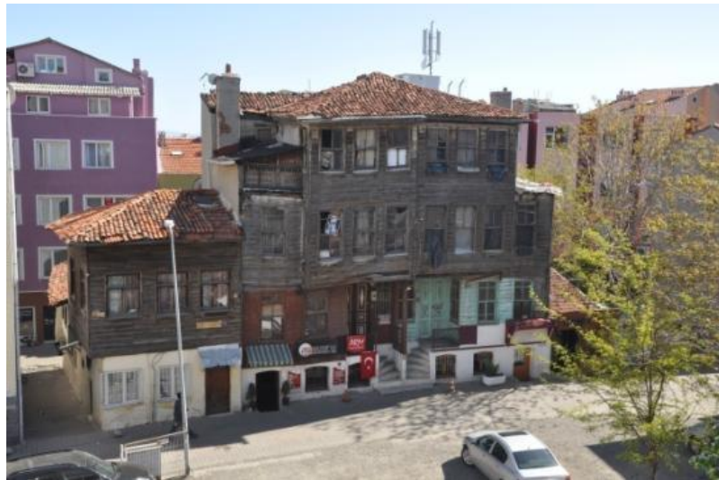
Şekil 4-118 15 ve 17 No'lu İkiz Yapı – Kuzey Cephesi - Eski Bedesten Sokak (Şık, Tekirdağ, 2012)
