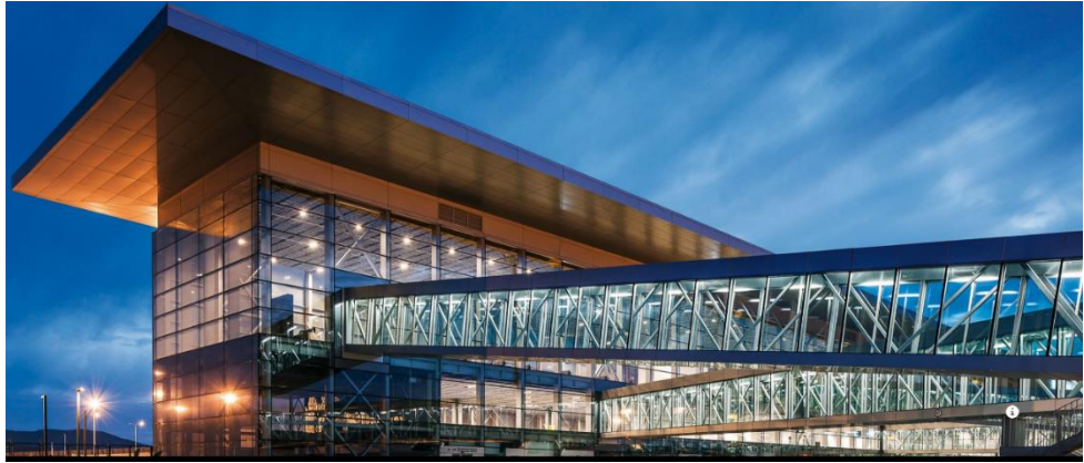
Şekil 2.24 Milas Bodrum Havalimanı Dış Hatlar Terminali binası, 2012
