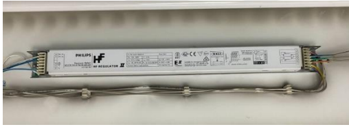
Şekil 4.4. Elektronik Balast
