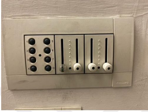
Şekil 4.3. DALI Sistem kontrol ünitesi
