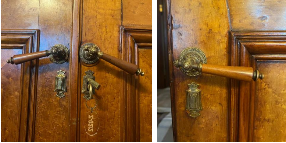
Görsel 5. 17. Kapı kolu pirinç ahşap malzeme detayı (Mavi, 2024)
