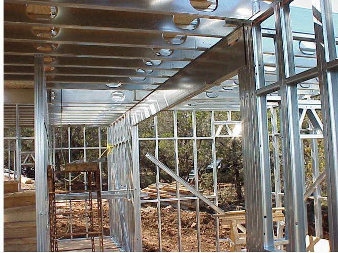
Şekil 1 Gövde boşluklu C kesit kiriş elemanlar
