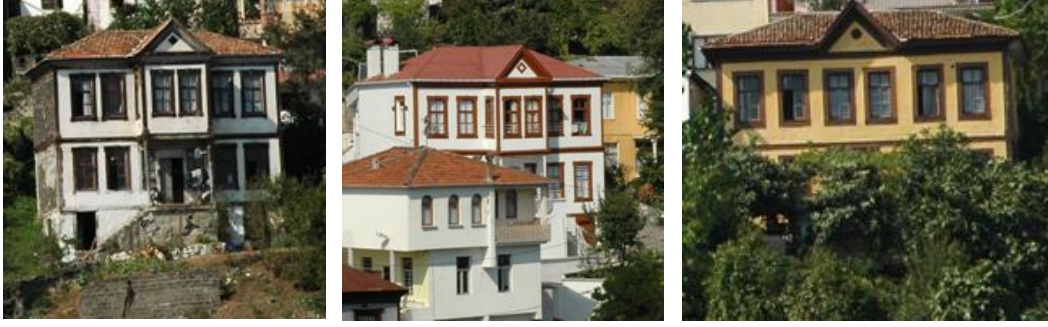
Şekil 17. Ahşap bantlarla yapılan kat ayrımları ve köşe kenarların çevrilmesi.
