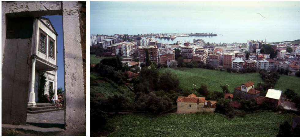
Şekil 12. Ön cephe ve sırtını sokağa çevirmiş, manzaraya yönelmiş geleneksel evler.
