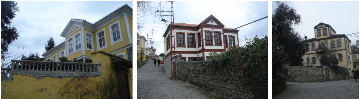
Şekil 6. Bahçe duvarları üzerinden yükselen geleneksel evler.
