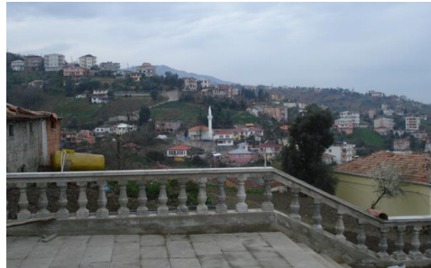
Şekil 19. Bahçe kenarlarında bulunan taş malzemeli korkuluklar.
