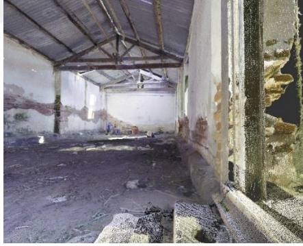
Şekil 4. 7. Yapı Temeli, Taşıyıcı Duvar ile Hatılları ve Çatı Strüktürü
