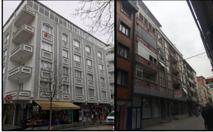
Şekil3.10. Çatı katının kapatılıp daireye dönüştürülmesine dair örnekler (Ertuğ arşivinden).
