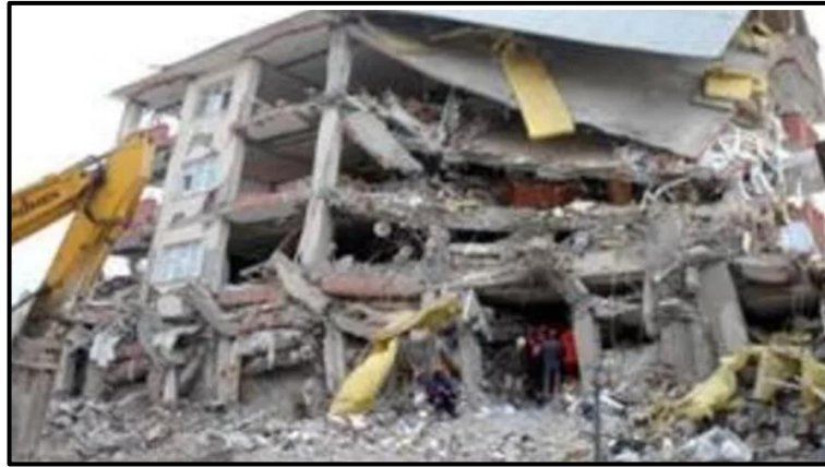
Şekil 3.1 2011 Van Depreminde yıkılan Nezir Baş apartmanı
