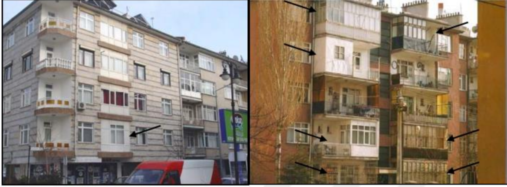
Şekil 3.11. Balkonun odaya eklenmesi ve kapatılmasına dair örnekler (Korur v.d.,2006).
