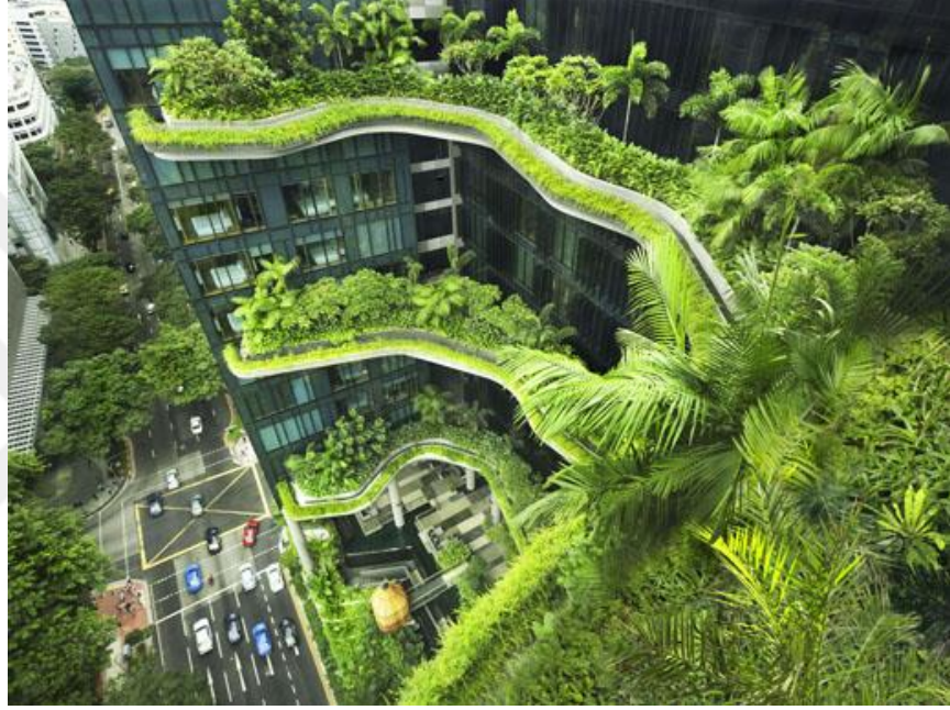
Şekil 4.2. Pakcroval Hotel Pickering Cephe Görünümü / Singapur (URL-11)
