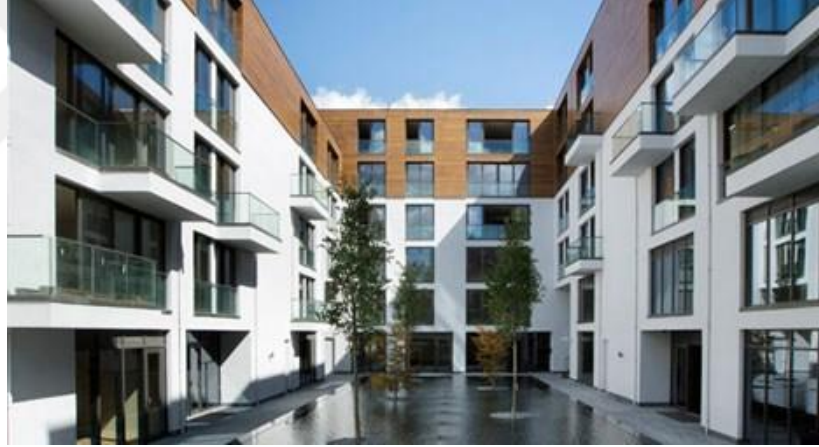
Şekil 4.10. Tekfen Bomonti Evleri Cephe Görünümü/ Şişli, İstanbul (URL-9)
