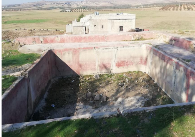
Ek 1.8 – Sulama havuzu (Kadılar Köyü)
