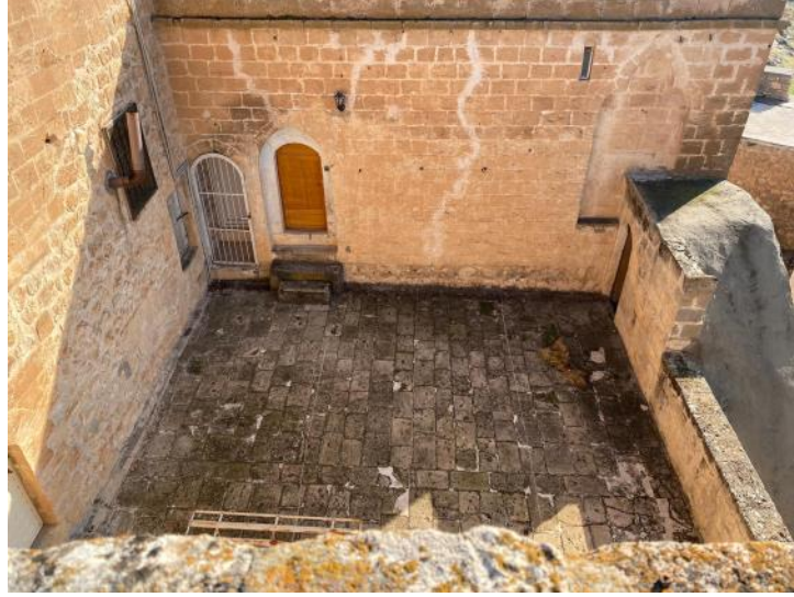
Şekil 4.58. Hacı Abdullah Bey Konağı'nın Zemin Katında Bulunan Teras Bölümü (Fotoğraf: Yücesoy, S. 2020).
