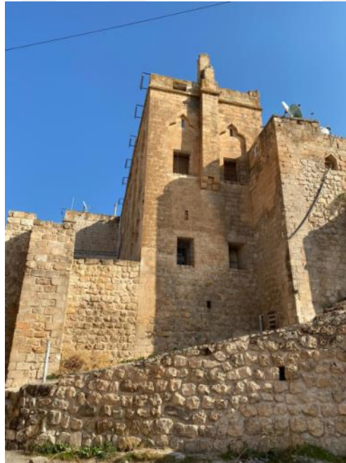
Şekil 4.49. Hacı Abdullah Bey Konağı'nın Sol Yönündeki Giriş Bölümü (Fotoğraf: Yücesoy, S. 2020).
