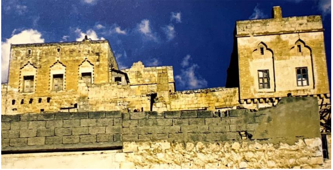
Şekil 4.87. Abdullatif Özbek Konağı'nın Dış Cephe Görünümü (Yıldız, 2011).
