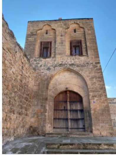
Şekil 4.50. Hacı Abdullah Bey Konağı'nın Orta Yönündeki Giriş Bölümü (Fotoğraf: Yücesoy, S. 2020).
