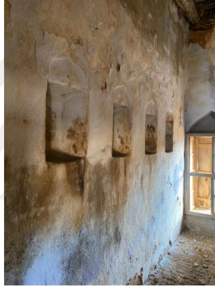
Şekil 4.90. Abdullatif Özbek Konağı’nın Ahır Bölümü (Fotoğraf: Yücesoy, S. 2020).
