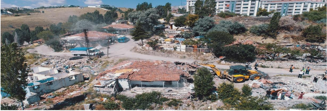
Şekil 2.28: Dikmen Vadisinde 2019 Yılında Gerçekleşen Gecekondu Yıkımı
