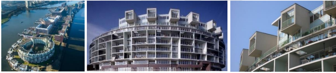
Şekil 8.13. Emerald Empire, Cephe Görünümleri ( https://www.gazeteduvar.com.tr ).
