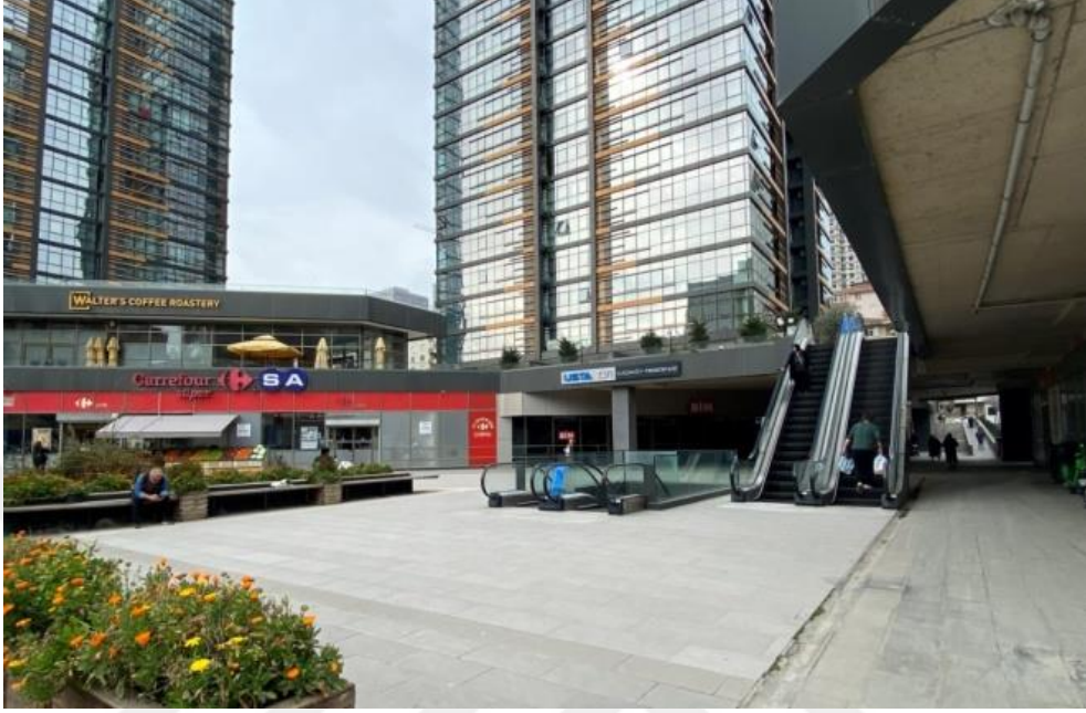
Şekil 3. 35 : İkinci zemin kata çıkan yürüyen merdivenler ve Cephe 2'ye çıkan yol (Yazar tarafından çekilmiştir, 2025)
