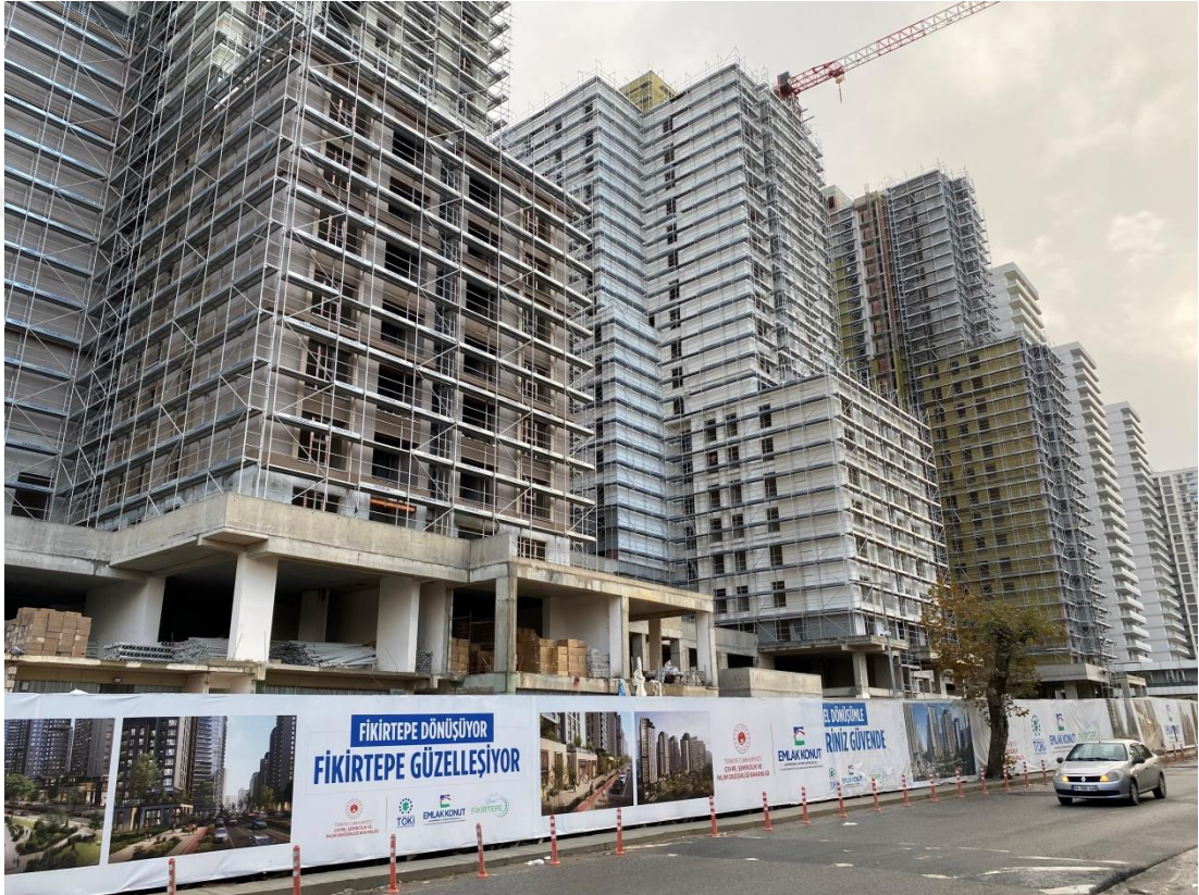
Şekil 3. 5 : Fikirtepe dönüşümü (Yazar tarafından çekilmiştir, 2025)
