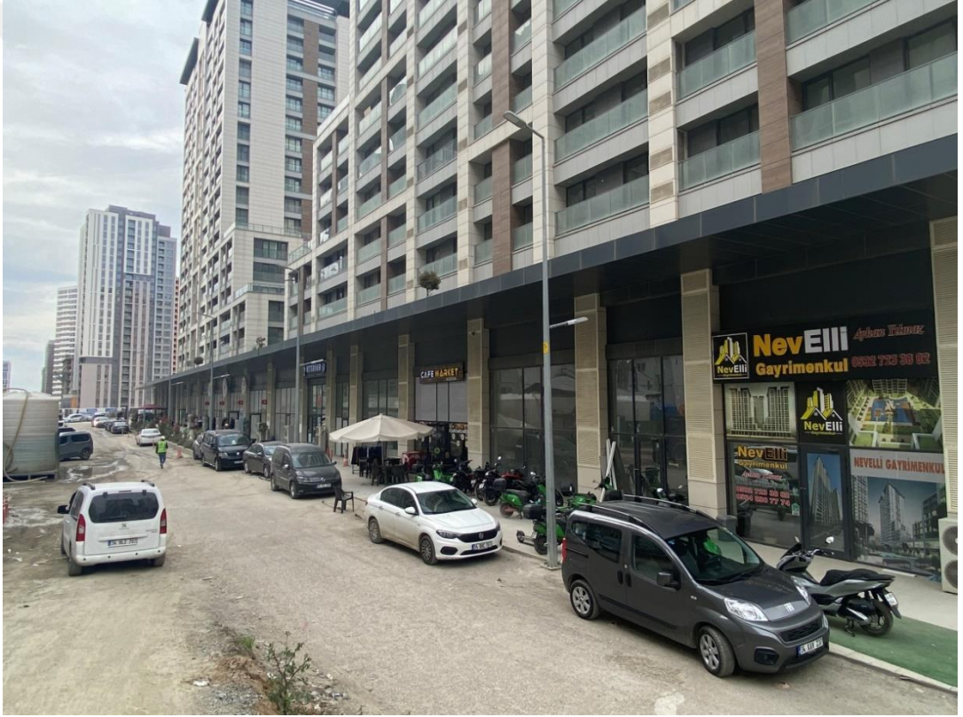
Şekil 3. 51 :Ada 3 Cephe 1 görünüşü (Yazar tarafından çekilmiştir, 2025)
