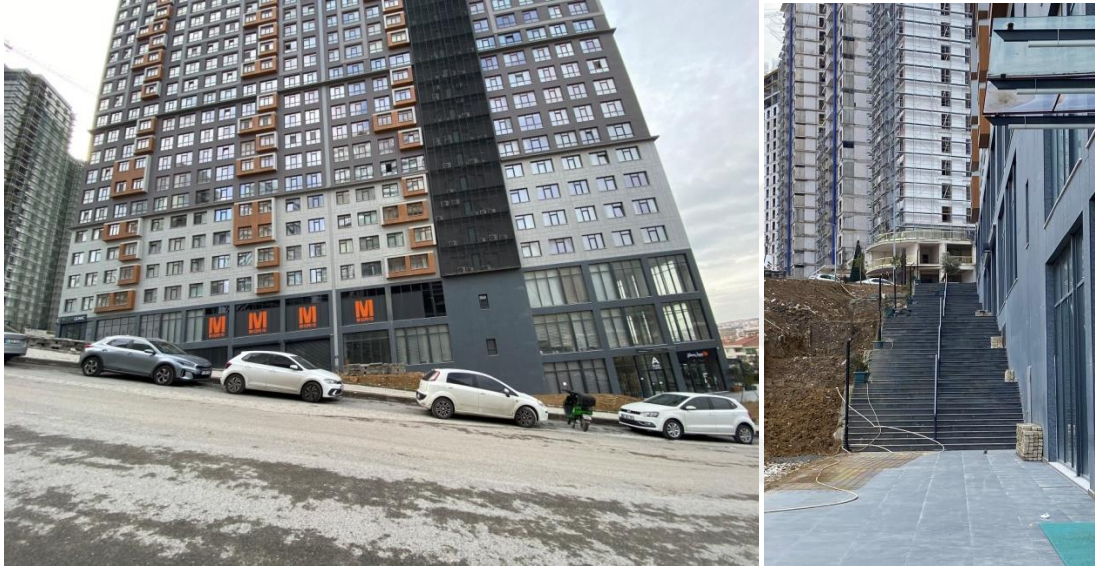
Şekil 3. 12 : Optimist Residence Cephe 1 (Yazar tarafından çekilmiştir, 2025)
