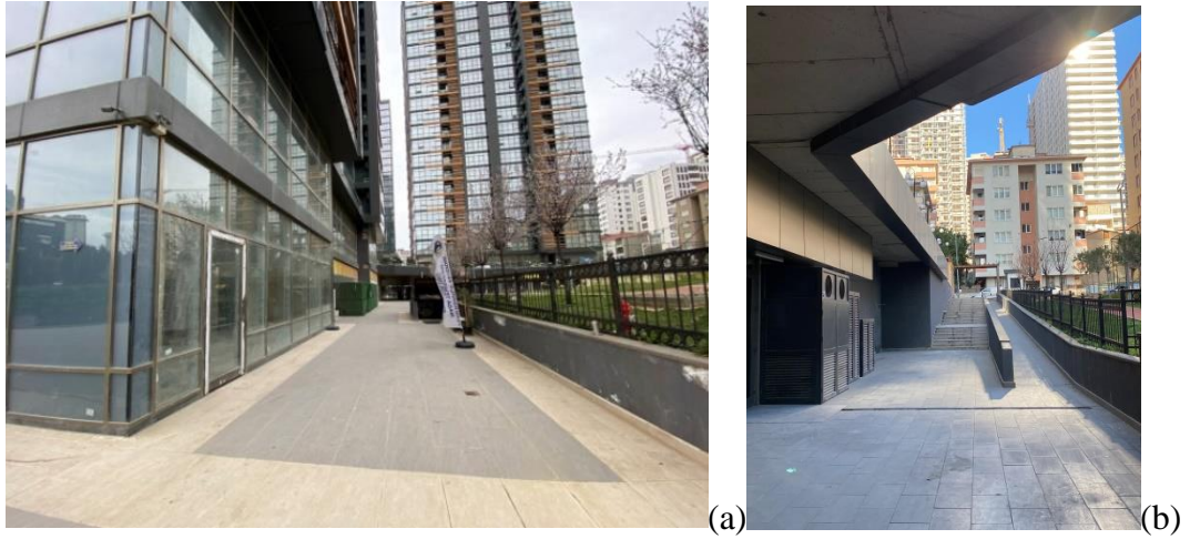
Şekil 3. 39 :Ada 2, Cephe 2 zemin katı (Yazar tarafından çekilmiştir, 2025)
