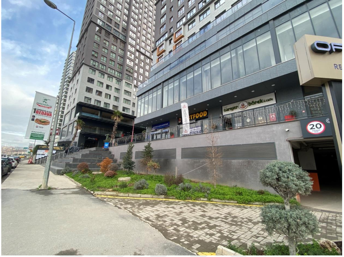
Şekil 3. 17 : Optimist Residence Cephe 3 (Yazar tarafından çekilmiştir, 2025)
