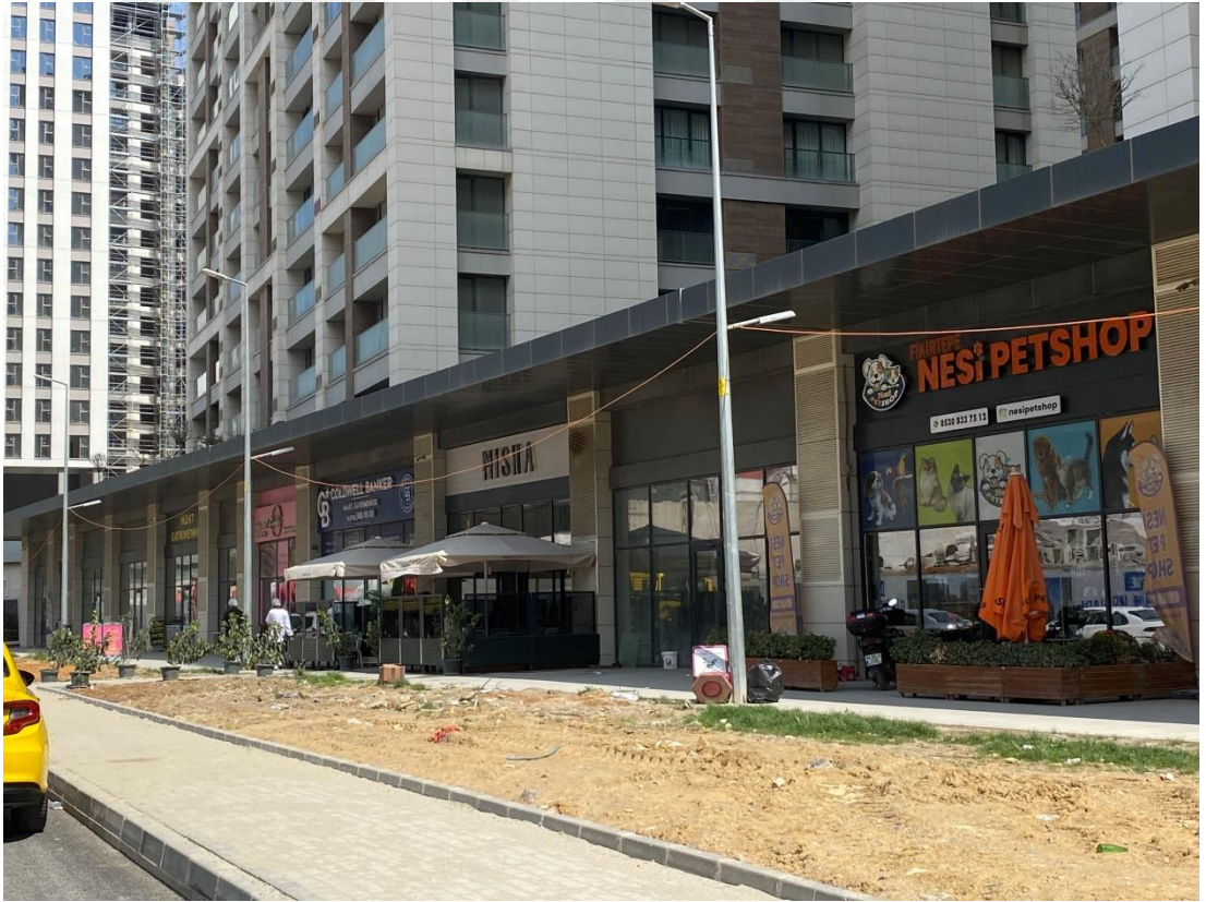
Şekil 3. 55 :Ada 3 Cephe 2 görünüşü (Yazar tarafından çekilmiştir, 2025)
