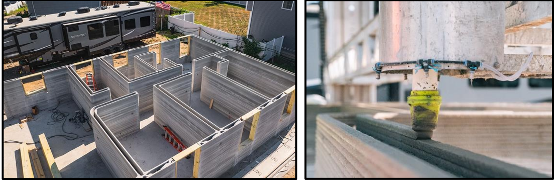
Resim 3.10: 3B yazıcı ile yapılan ev (Sq4d, 2022)
