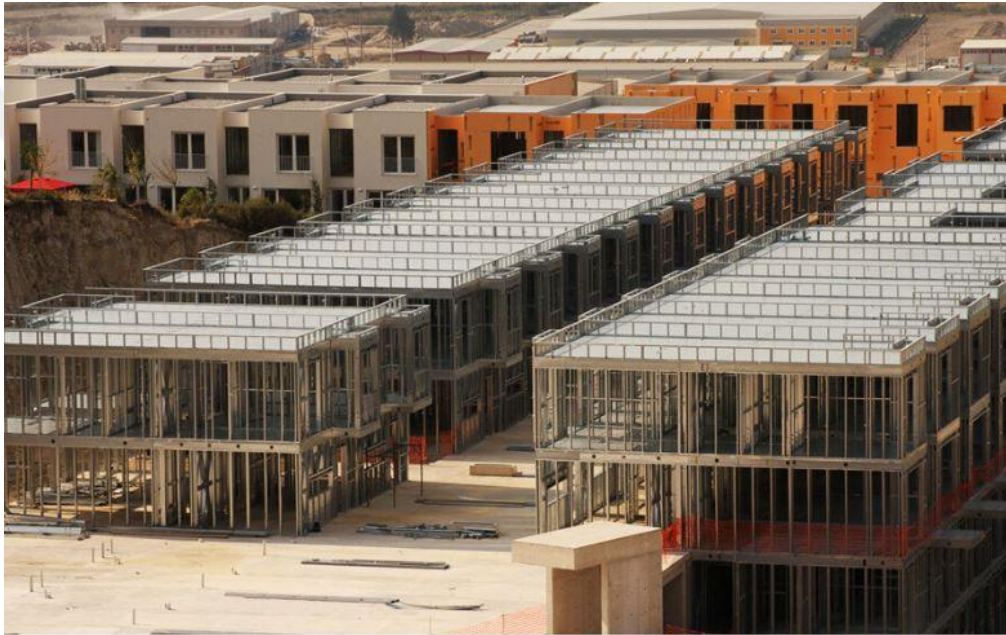
Şekil 4.15. 35. Sokak Projesi Çelik Sistem Uygulaması (URL-35)
