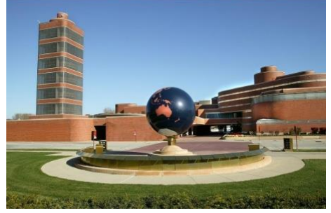
Şekil 23. Johnson Wax Headquarters Görünüşü
