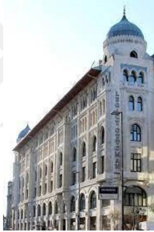
Şekil.16 Vakıf Han Binası Görünüş
