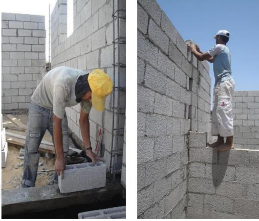
Şekil 2.3 Gazze Şeridi'ndeki Ev Sahiplerinin Kendileri veya Usta Tarafından Yapılan İnşaat (Al Qudwa S. , 2013)
