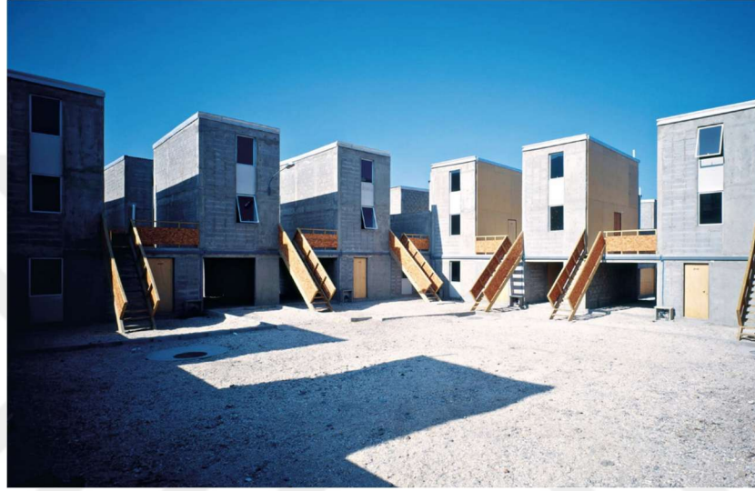
Şekil 3.5 Yarım Ev / Half House - Genel Görünüm (URL-15)
