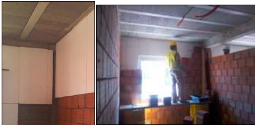
Şekil 4.13. Duvarların ısı yalıtımı ( https://alomrane.gov.ma , 2019)
