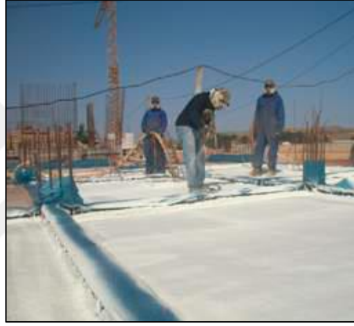
Şekil 4.15. Ara katlarda kullanılan poliüretan izolasyonu ( https://alomrane.gov.ma , 2019)
