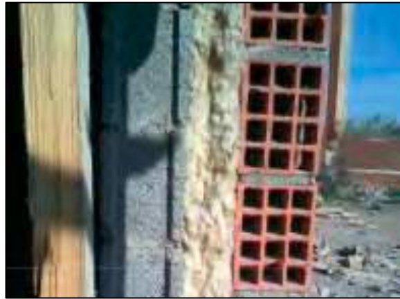
Şekil 4.21. Dar AMYS'ın dış duvarın kesiti (Universite Smlalya, 2019)
