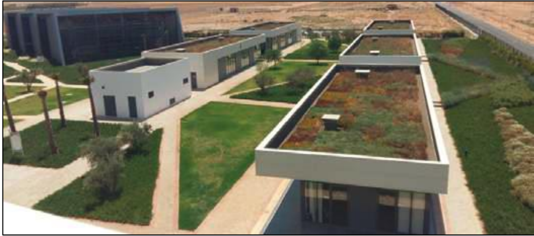
Şekil 4.44. Yeşil çatı binada kullanımı ( https://ifmeree.ac.ma , 2015)
