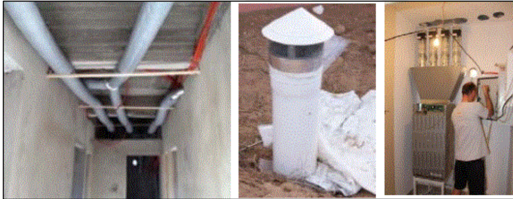
Şekil 4.38. Kanada kuyusu ve ısı pompası fotoğrafları ( https://www.construction21.org )
