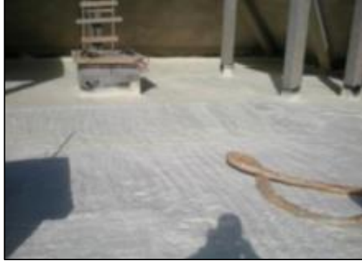
Şekil 4.14. Al Karama çatısında poliüretan uygulaması ( https://alomrane.gov.ma , 2019)
