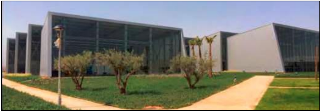
Şekil 4.42. Kuzey cephesinden ve çatı katlarda tam cam kaplaması
