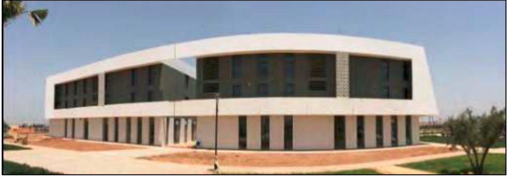
Şekil 4.41. IFMEREE doğu cephesi fotovoltaiik ( https://ifmeree.ac.ma , 2015)
