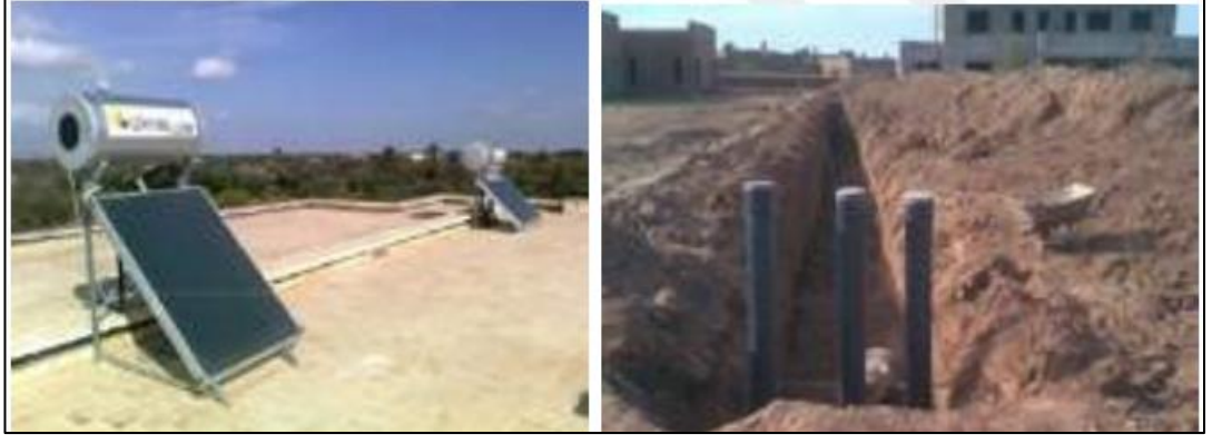
Şekil 4.22. Dar AMYS'de kullanılan güneş kollektörü ve EAHX sistemleri, (In marrakesh, 2018)
