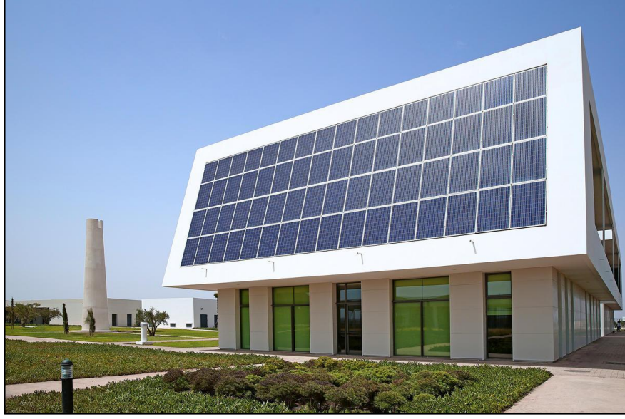
Şekil 4.40. Güney cephedeki fotovoltaiik panelleri ( https://ifmeree.ac.ma , 2015)
