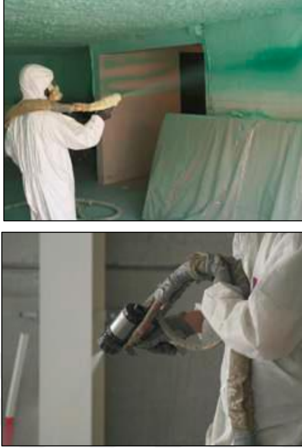
Şekil 4.3. Püskürteme poliüretan uygulaması ( https://archi.ac.ma , 2017).
