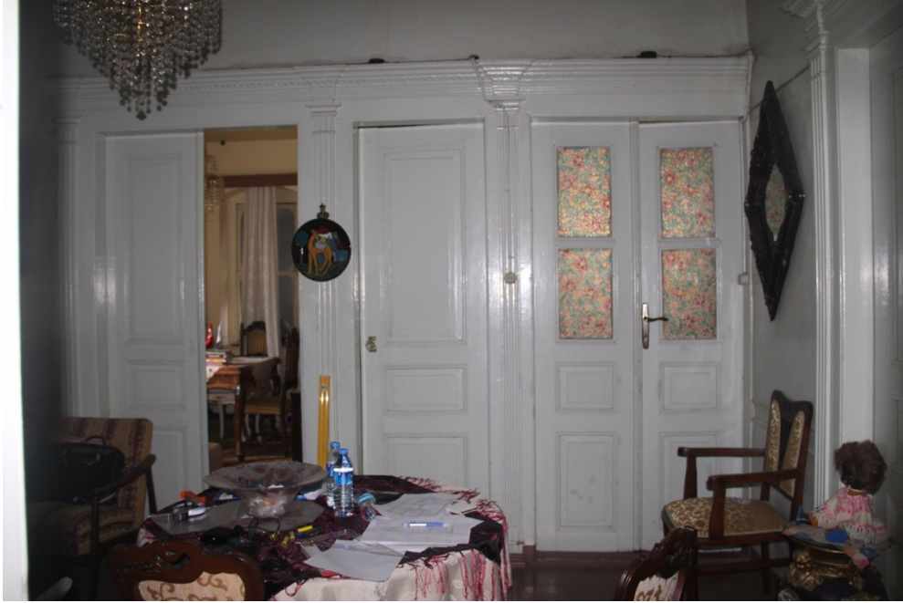
Şekil 3.63: Çift kanatlı (KZ02) , tek kanatlı (KZ03) , camlı çift kanatlı (KZ04) kapı örnekleri (Parlak yıldız, 2016)
