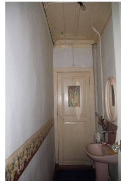
Z-08 batı duvarı
