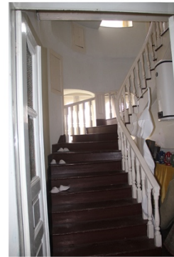
Z-01 mekânından merdiven boşluğuna bakış
