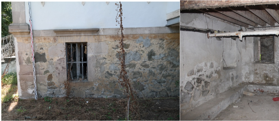
Şekil 3.55: Tiralizade Hasan Bey Konağı'nın bodrum kat duvarlarının dıştan ve içten görünüşü (Parlakıyıldız, 2016)
