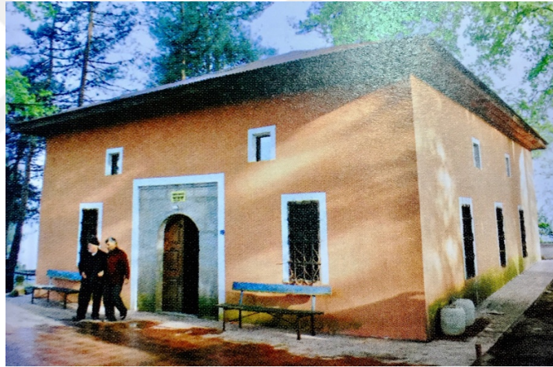
Şekil 2.23: Şihkiran (Eski) Camii (İltar, 2014, s.242)
