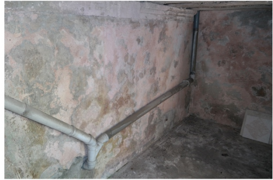
B-03 mekânının güney duvarı
