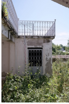
B-04 mekânının giriş kapısı
