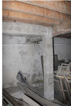
B-02 mekânı betonarme kolon
