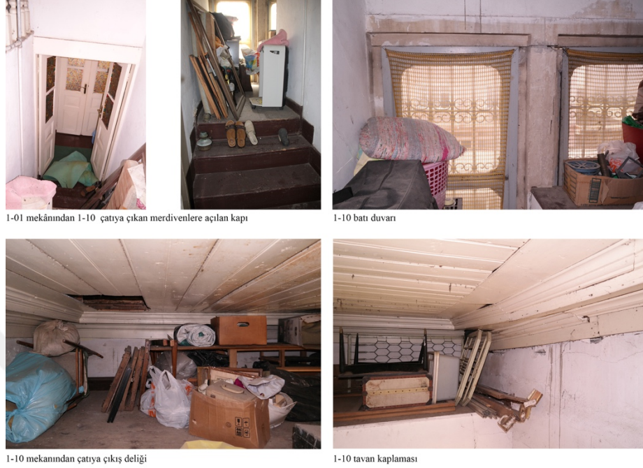
Şekil 3.45: 110 mekânı (çatı çıkış sahanlığı)
