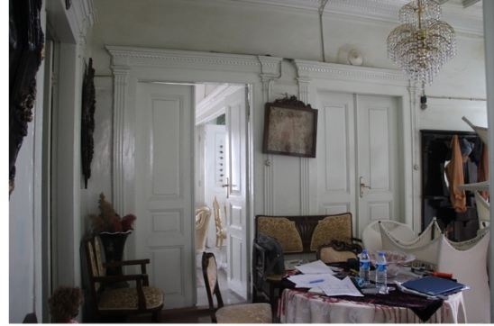
Z-01 doğu duvarı
