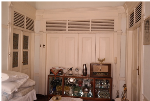
Şekil 3.65: Ahşap çatalı ızgara kafes tepelikli kapı örneği (K103, K111) (Parlak yıldız, 2016)
