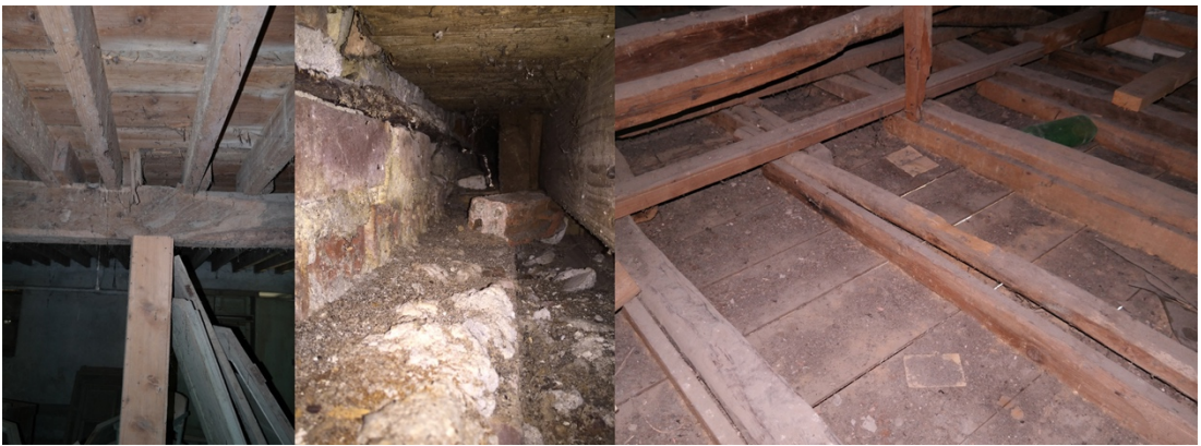
Şekil 3.58: Tiralizade Hasan Bey Konağı'nın döşemelerinin görünüşleri (Parlak yıldız, 2016)
