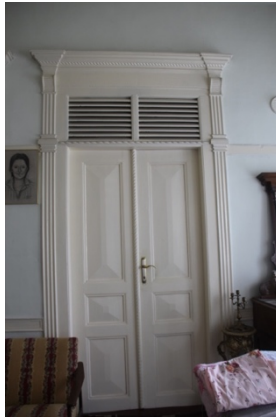
Şekil 3.65: Ahşap çatalı ızgara kafes tepelikli kapı örneği (K103, K111) (Parlak yıldız, 2016)
