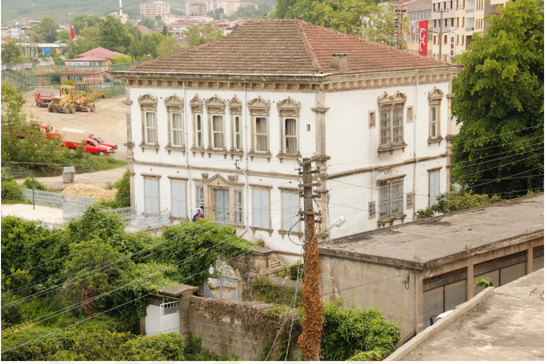
Şekil 3.51: Tiralizade Hasan Bey Konağı'nın kuzey cephesi (Parlakyıldız, 2016)
