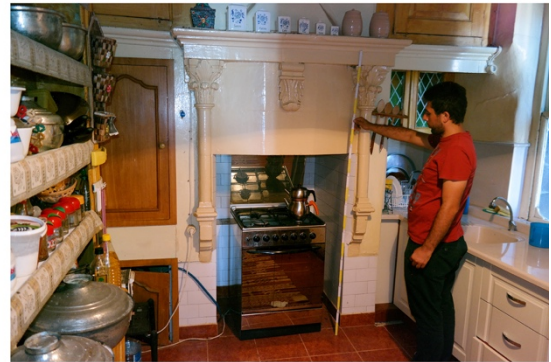
Z-06 batı duvarı
