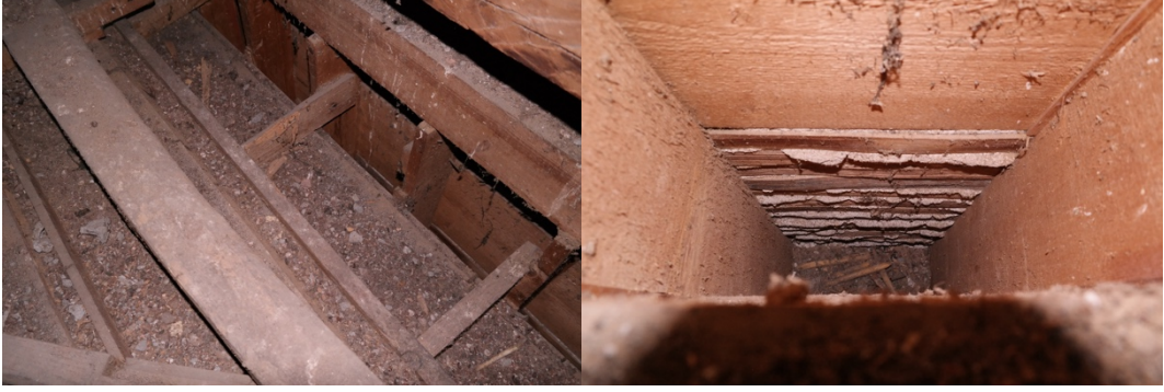
Şekil 3.57: Tiralizade Hasan Bey Konağı çatı arasından görülen iç duvar kesiti (Parlak yıldız, 2016)
