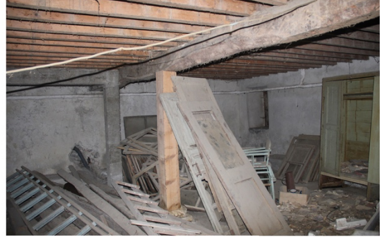
B-02 mekânı kuzeydoğu köşesi
