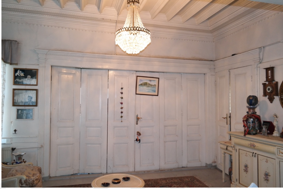
Şekil 3.64: Altı kanatlı katlanır ahşap kapı (KZ14) örneği (Parlak yıldız, 2016)
