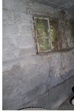
B-04 mekânının doğu duvarı
