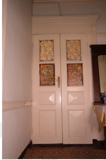
Şekil 3.66: Üst tablası camlı olan ahşap iki kanatlı kapı örneği (K101) (Parlak yıldız, 2016)
