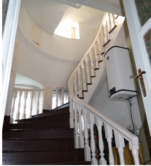
Şekil 3.25: Konağın zemin katını birinci kata bağlayan merdiven
