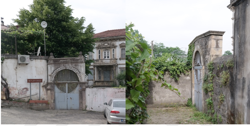
Şekil 3.61: Konağın Ordu Caddesi ve Alt Sokaktan bahçe giriş kapıları (solda güney bahçe kapısı, sağda kuzey bahçe kapısı) (Parlakııldız, 2016)
