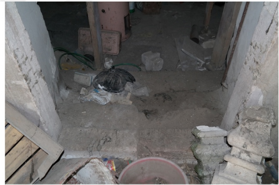
B-01 mekânından, B-02 mekânına geçilen açıklık
