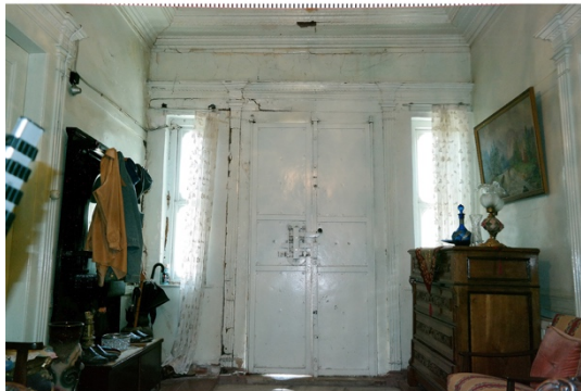
Z-01 güney duvarı
