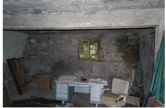
B-04 mekânının doğu duvarı
