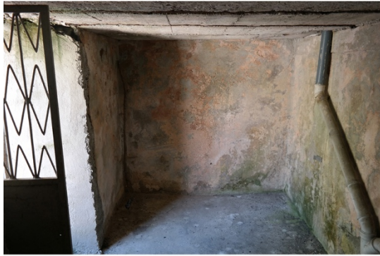
B-03 mekânının doğu duvarı
