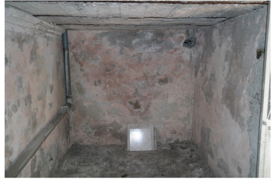
B-03 mekânının batı duvarı
