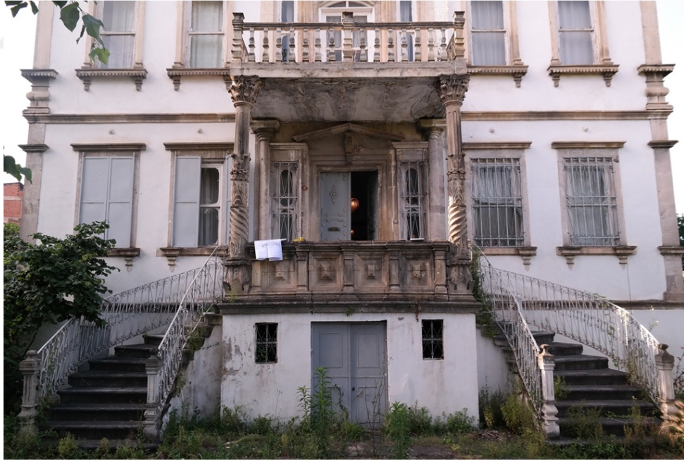
Şekil 3.14: Konağın güney cephesinde bodrum kat ve zemin kat girişleri
