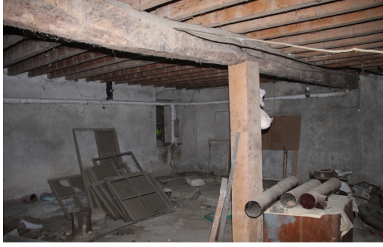
B-02 mekânı güneydoğu köşesi
