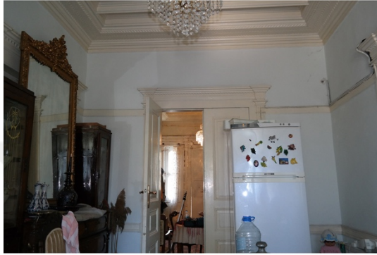
Z-02 güney duvarı
