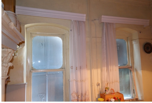
Z-06 kuzey duvarı
