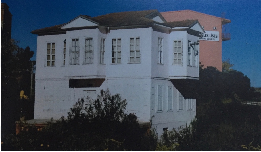
Şekil 2.25: Tiralizade Osman Bey Konağı (İltar, 2014:245)
