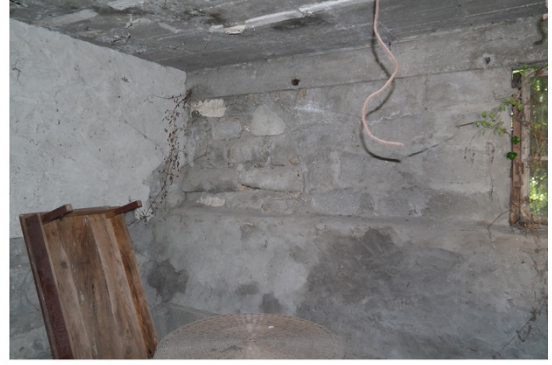
B-04 mekânının doğu duvarı
