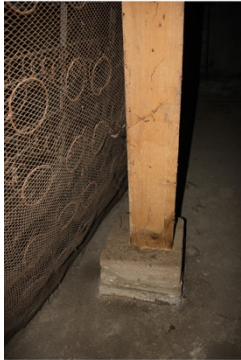
B-02 mekânı ahşap dikmeler
