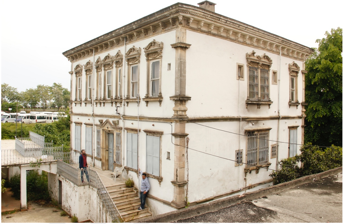
Şekil 3.53: Tiralizade Hasan Bey Konağı'nın batı cephesi (Parlakııldız, 2016)
