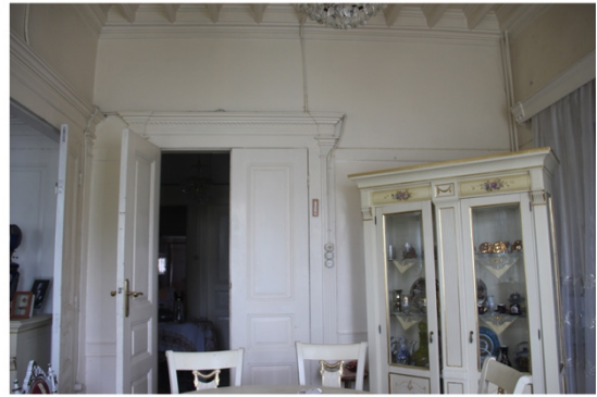
Z-05 batı duvarı
