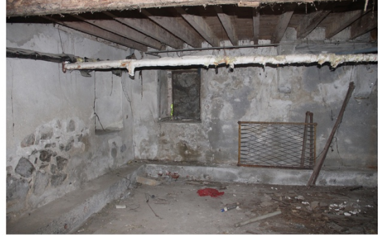
B-02 mekânı güneybatı köşesi
