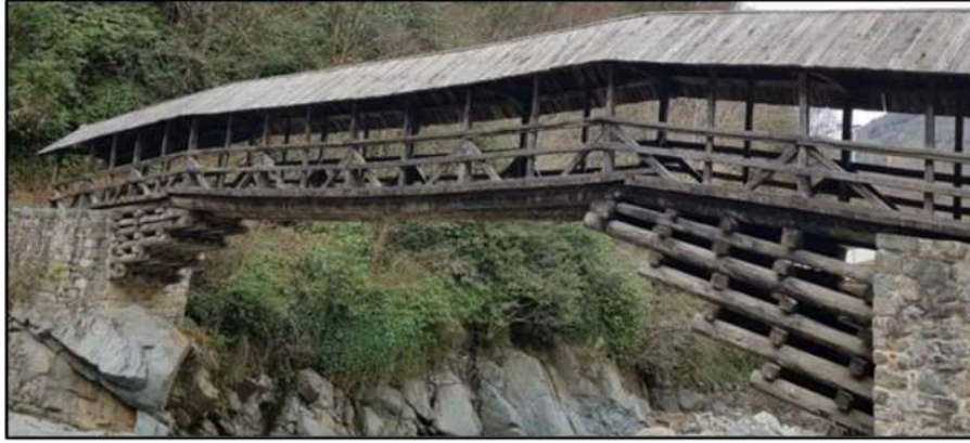
Şekil 11: Ana ve konsol kirişlerden oluşan kütle biçimi; Buzlupınar Köprüsü, Rize-Çayeli-Buzlupınar köyü (Yazarın Arşivi)
