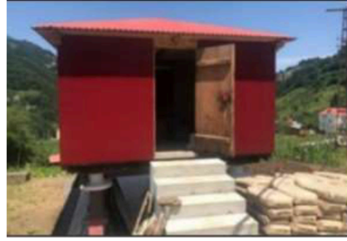
Şekil 19a (solda): Yerel olmayan bir malzemeye zemine sabit biçimde inşa edilen merdiven; Trabzon-Tonya-İskenderli Mahallesi (Yazarın Arşivi)
