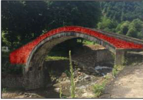
Şekil 8a (solda): Moloz taştan inşa edilen tempan duvar; Ortaköy Köprüsü, Rize-Hemşin-Çaneva Köyü (Yazarın Arşivi)
