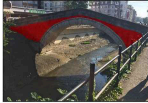
Şekil 8a (solda): Moloz taştan inşa edilen tempan duvar; Ortaköy Köprüsü, Rize-Hemşin-Çaneva Köyü (Yazarın Arşivi)
