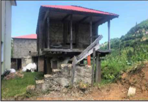
Şekil 19a (solda): Yerel olmayan bir malzemeye zemine sabit biçimde inşa edilen merdiven; Trabzon-Tonya-İskenderli Mahallesi (Yazarın Arşivi)
