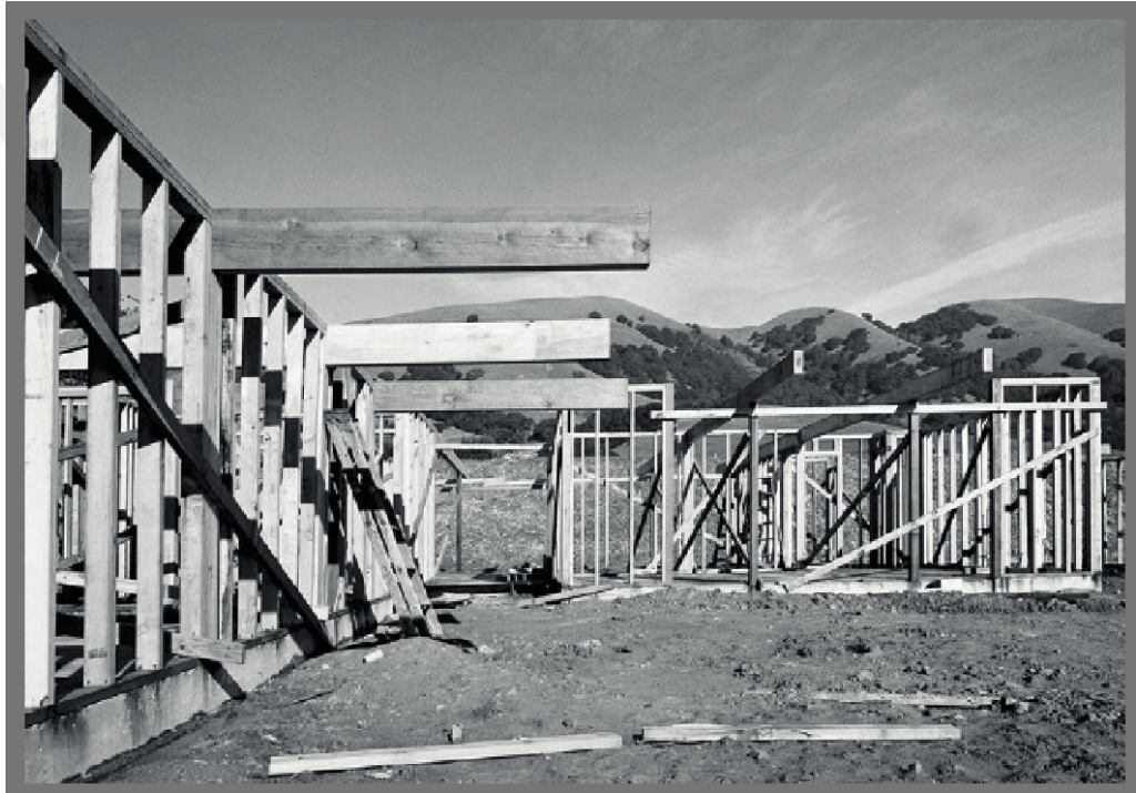
Görsel 22 : Kiriş – kolon konstrüksiyon methodunu gösteren fotoğraf. 1950
