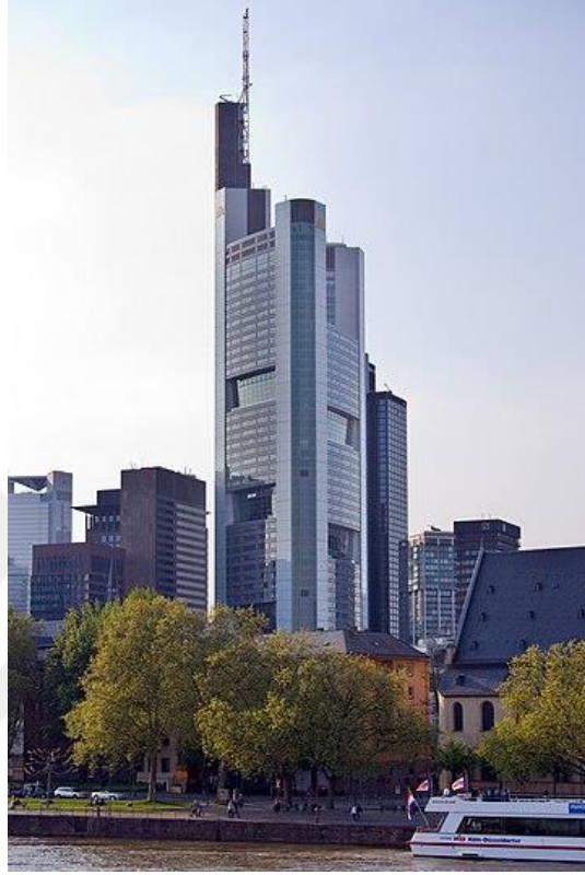
Şekil 3.46. Commerzbank Genel Merkez Binası ( https://en.wikipedia.org/wiki/Commerzbank_Tower )
