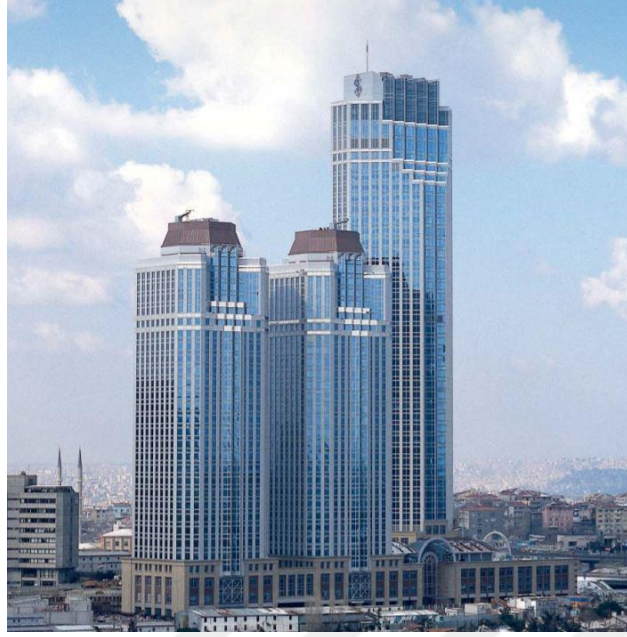
Şekil 3.64. İş Bankası Kuleleri
