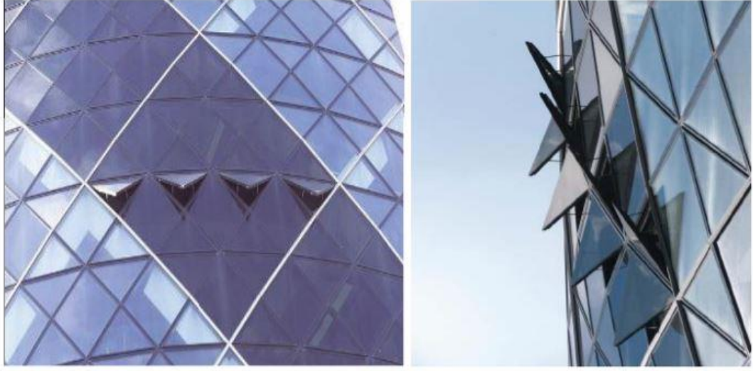
Şekil 5.24. Swiss Re Binası, doğal havalandırma açılır kanat sistemi (Özdemir, 2014).
