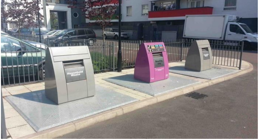
Şekil 1.3 - Örnek Atık Toplama Noktası, Çöp Konteyniri
