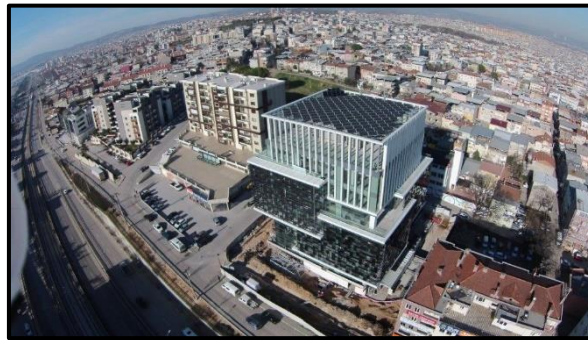
Şekil 4. 18: Bursagaz Yeni Yönetim Binası ( https://www.altensis.com )
