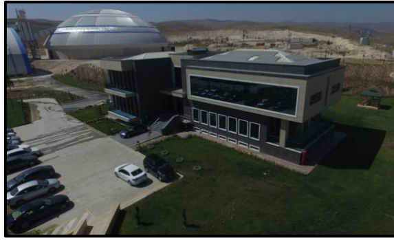
Şekil 4. 20: Afyon Çimento İdari Binası ( http://www.yesilbinadergisi.com )
