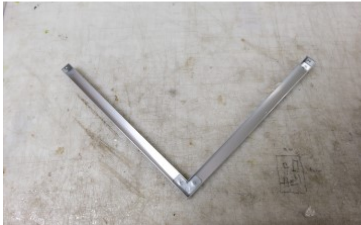
Şekil 4.6: Cephe elemanını yapıya bağlayan ray sistemi.
