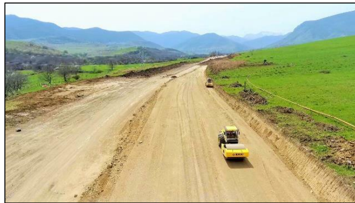
Şekil 3: Zafer yolunun yapım aşaması (URL 1)
