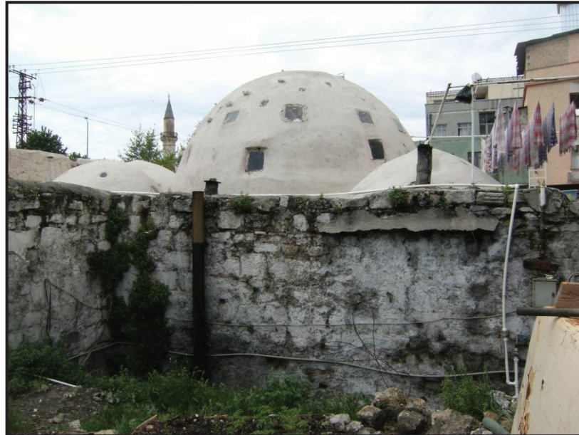
Şekil 3.154 Yeni Hamam Doğu Cephesinden Görünüş (Öztürk, 2012)
