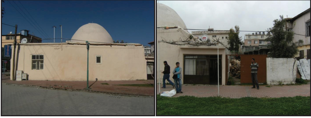
Şekil 3.10 Yeni Hamam'ın Güney Cephесinin Mevcut Durumu (Solda) (Öztürk, 2012)
