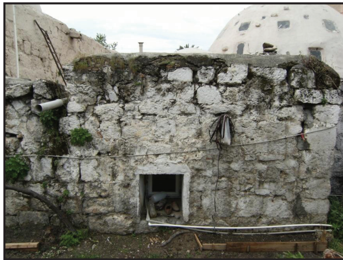
Şekil 3.79 Helanın Doğu Duvarındaki Pencere Açıklığı (Öztürk, 2012)
