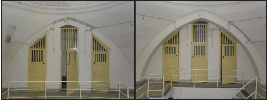
Şekil 3.67 101 Mekanı Kuzey Tarafı (Solda) (Öztürk, 2012)
