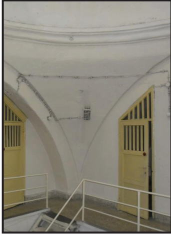
Şekil 3.43 Z03 Mekanı Pandantif Detayı (Solda) (Öztürk, 2012)
