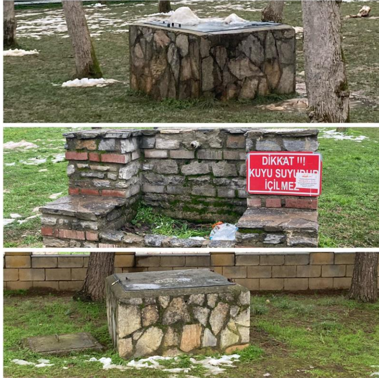
Şekil 5. 8. Özgürlük Deprem Parkında Görünen Su Depoları (Kişisel Arşiv)
