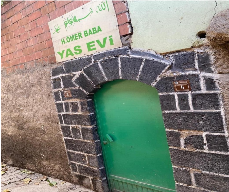
Resim 16: Ömer Uçaş'ın Diyarbakır'da bulunan dergâhının girişi. (Havva Eylem Dursun özel arşivine aittir.)
