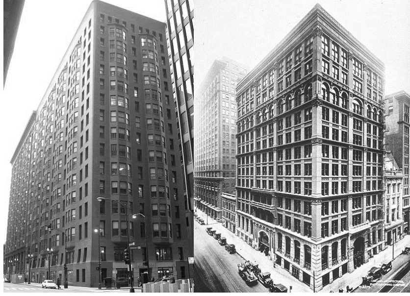
Resim 2.11: Monadnock Binası (Wikipedia) ve Home Insurance Binası (Wikipedia)
