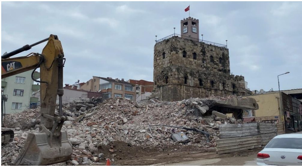
Şekil 4.24: Kent Meydanı yıkım çalışmaları (Yazarın özel arşivi).
