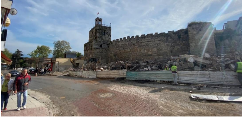
Şekil 4.22: İl Genel Meclisi Binası yıkım çalışmaları (Yazarın özel arşivi).
