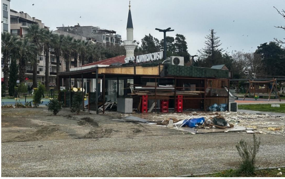
Şekil 5.27: Proje alanı içerisinde, vaziyet planında yer almayan işgaller, Aralık 2024 (Yazarın özel arşivi).
