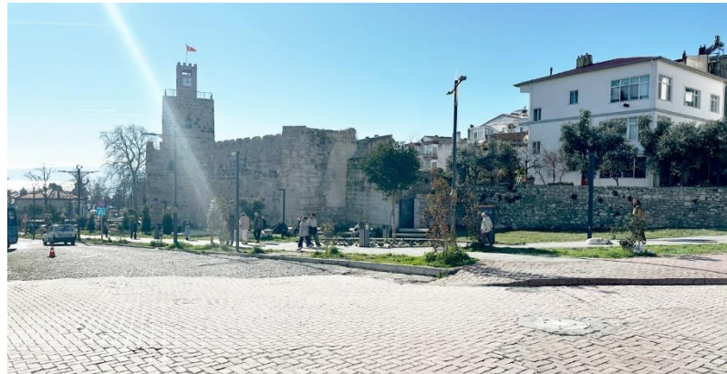
Şekil 5.42: Sinop Kent Meydanı ve Millet Bahçesi Projesi'nden sonra Sinop Kalesi Doğu Surları (Yazarın özel arşivi).
