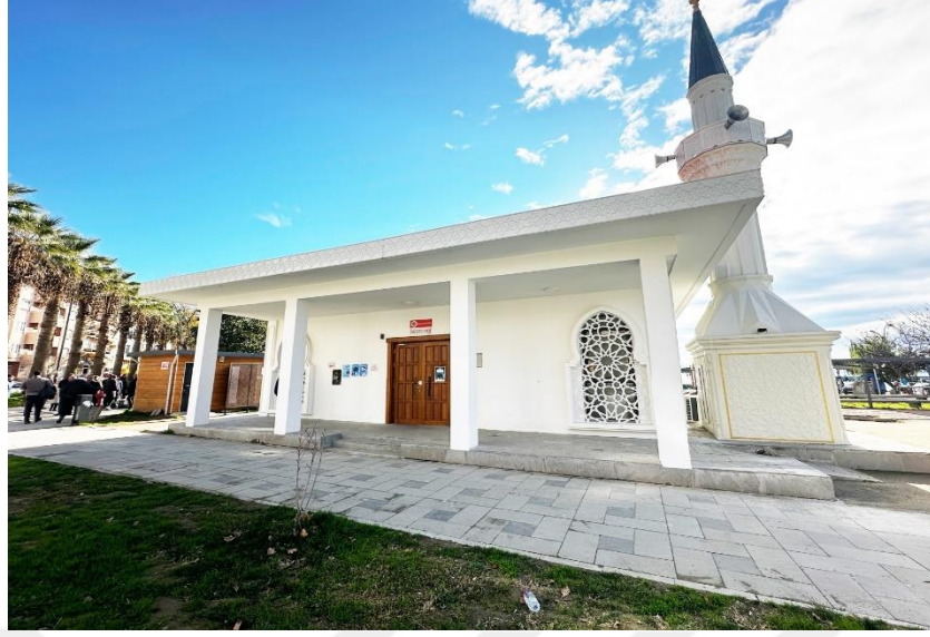
Şekil 4.32: Sinop Kent Meydanı ve Millet Bahçesi Projesi kapsamında inşa edilen İskele Camii (Yazarın özel arşivi).
