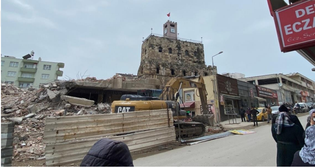
Şekil 4.23: Kent Meydanı yıkım çalışmaları (Yazarın özel arşivi).
