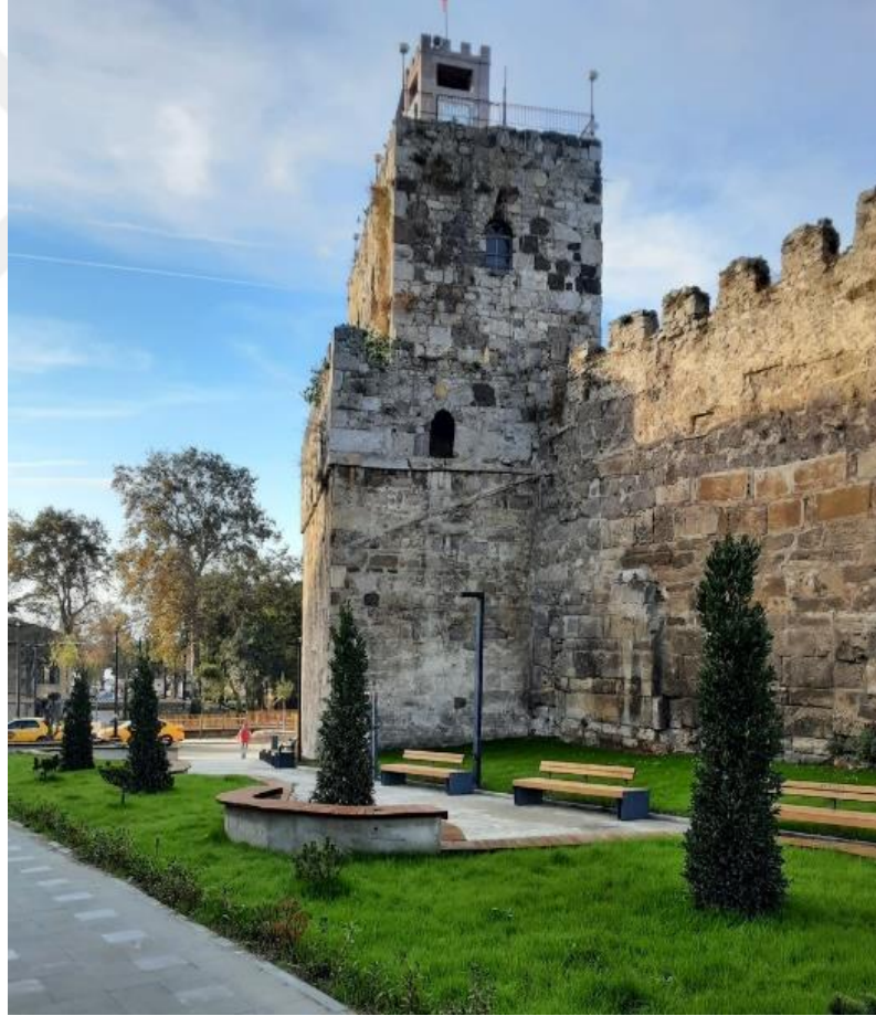
Şekil 5.35: Saat Kulesi ve Doğu Surları önünde yapılan peyzaj düzenlemesi(Yazarın özel arşivi).
