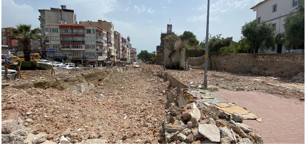
Şekil 4.25: Kent Meydanı yıkım çalışmaları (Yazarın özel arşivi).
